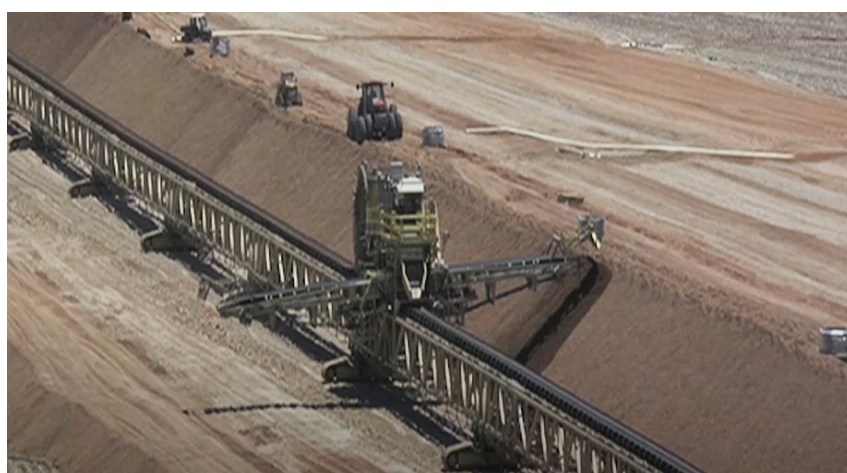
Figura 2.16 – Processo de estaqueamento e compactação na mina de Penãsqito (Goldcorp, 2018).
