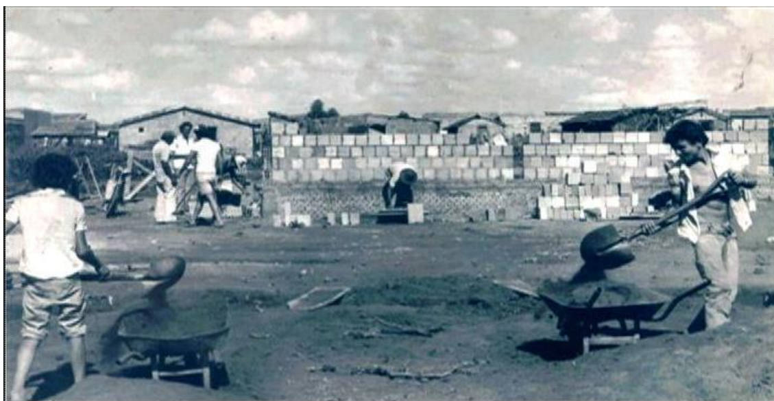
Figura 39 – Construção no bairro Jardim Nova Esperança
