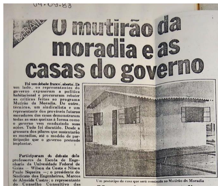
Figura 63 – Protótipo da casa da Vila Mutirão
