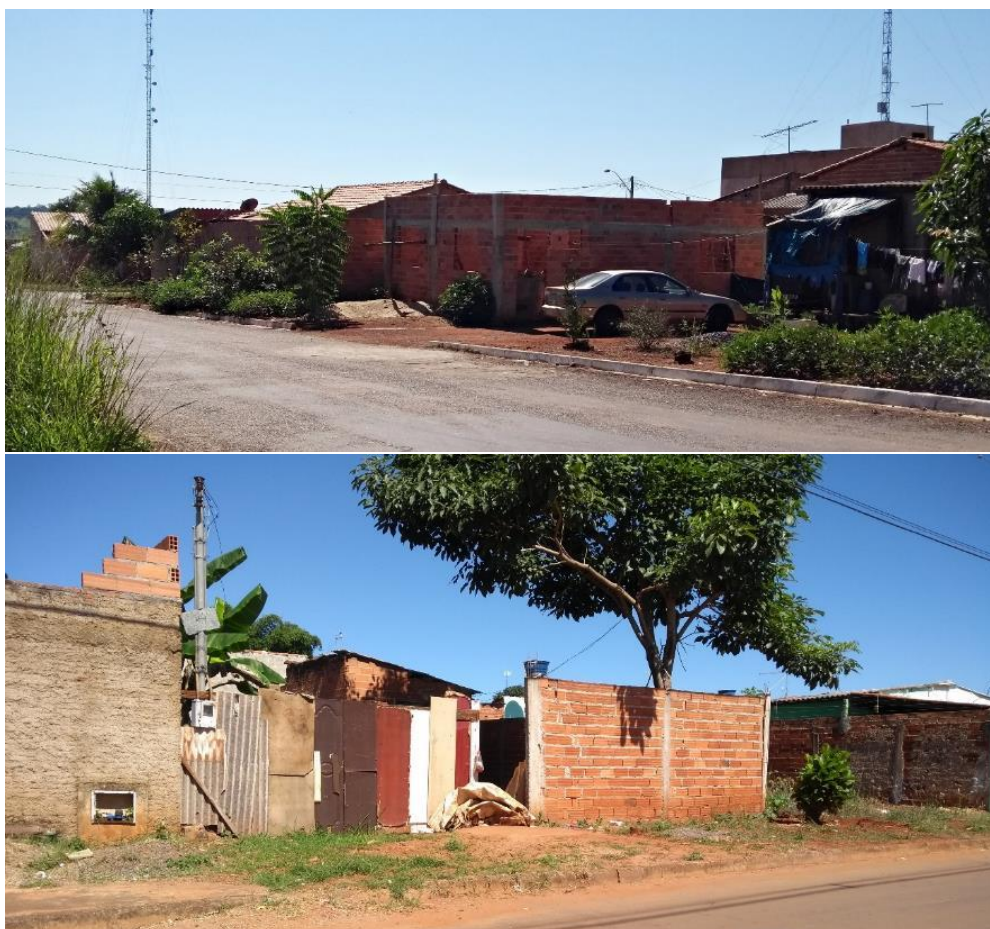
Figura 106 – Foto das casas do Setor Estrela D'Alva
