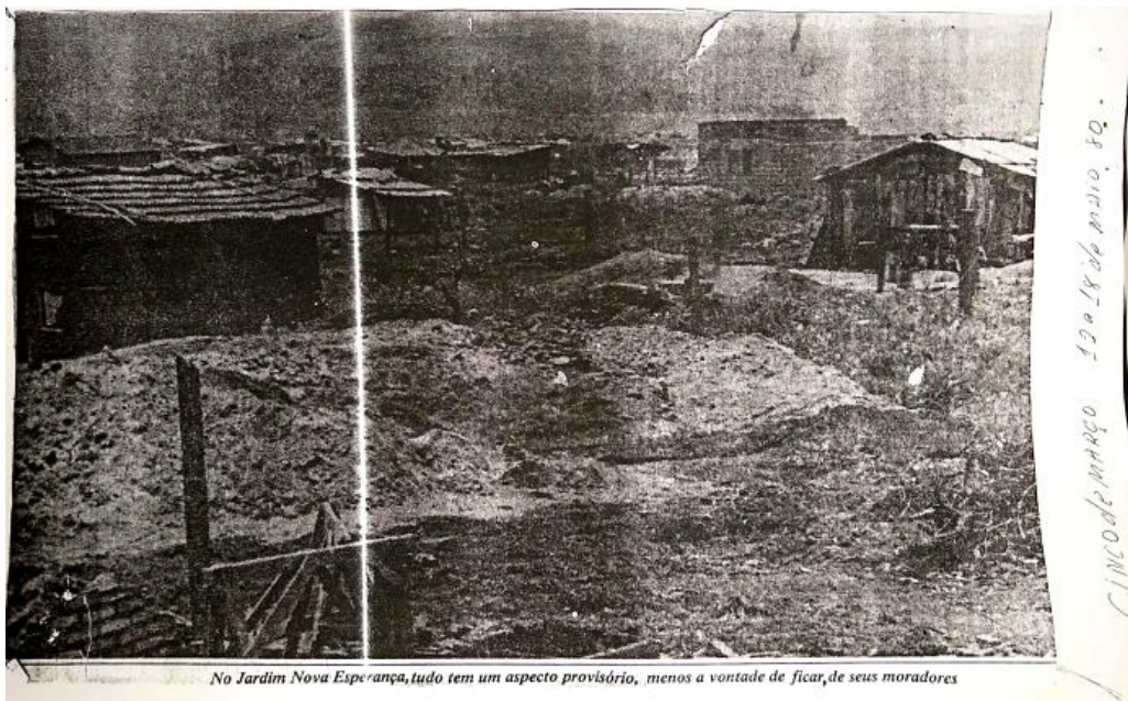
Figura 33 – Construções levantadas no Jardim Nova Esperança
