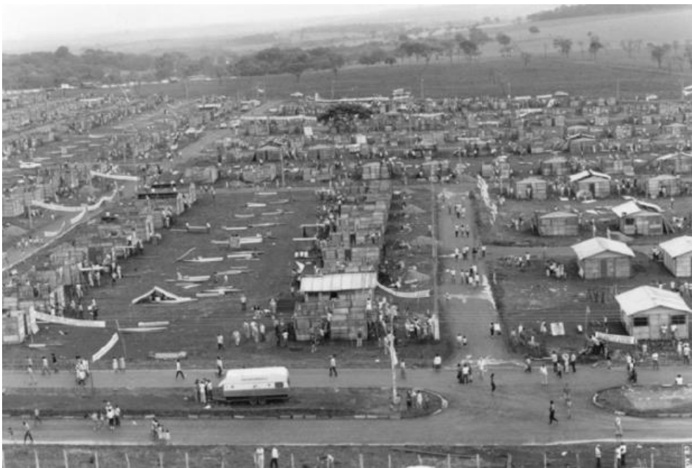
Figura 64 – Construção da Vila Mutirão
