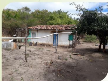
▪ Casa antes da obra do CAC.
