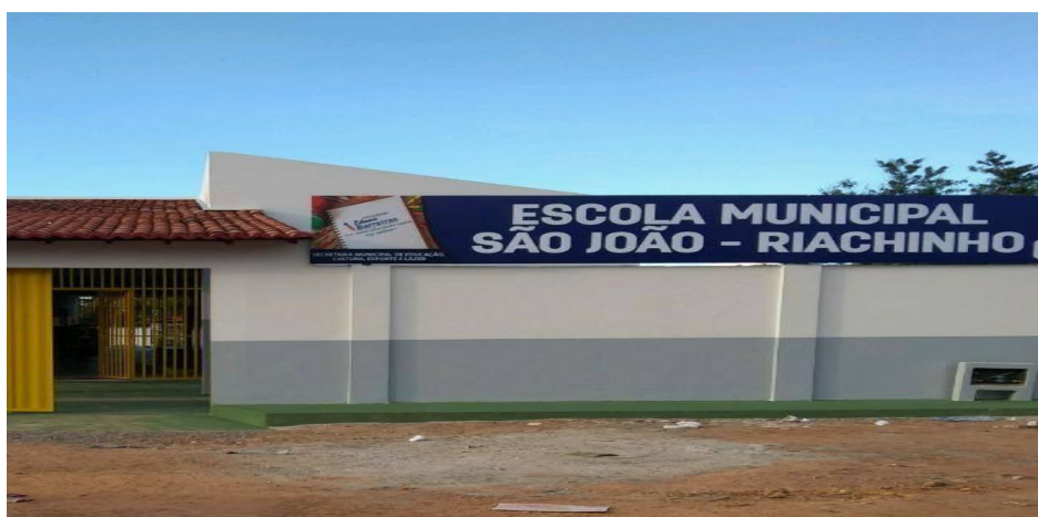
Imagem 03 – Escola São João após a reforma realizada em 2018. Fonte: arquivo pessoal da autora.
