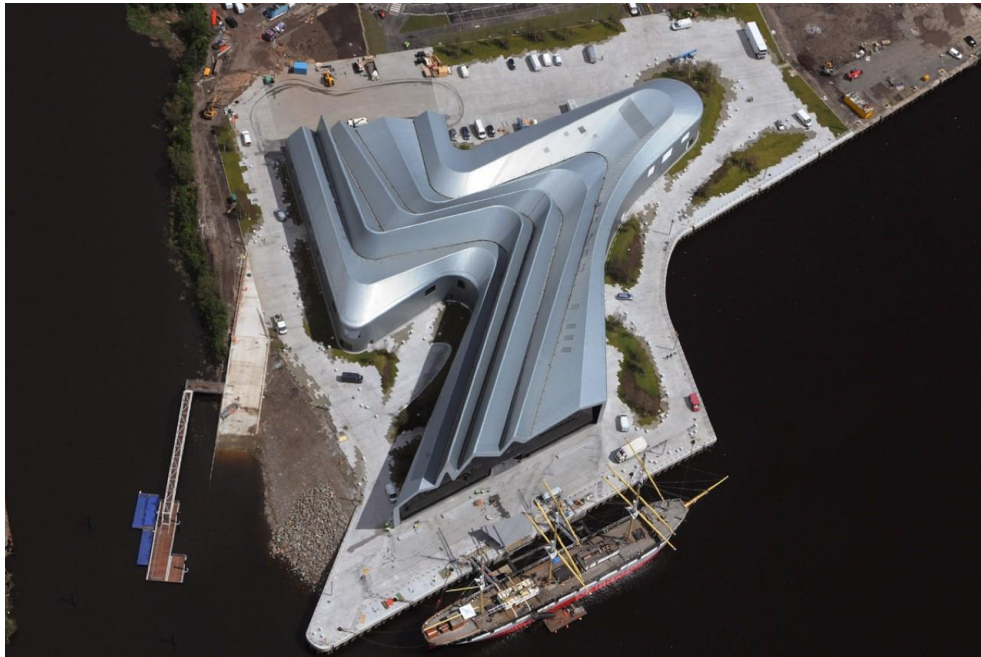
Figura 07: Museu Riverside de Zaha Hadid Architects e BuroHappold Engineering, em Glasgow, Reino Unido.
