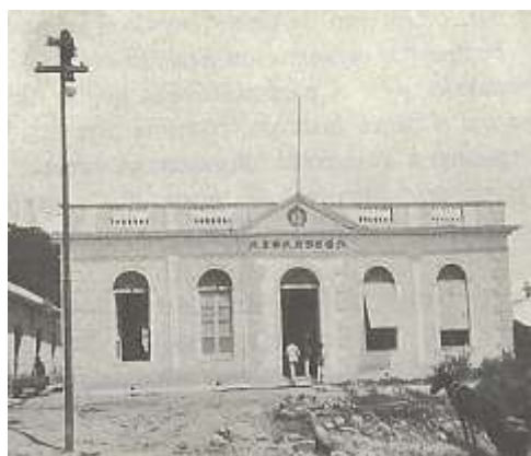
Imagem 7 - Corumbá. Prédio da Alfândega, junto ao Porto de Corumbá. Fonte: Álbum Graphico do Estado de Mato Grosso. p.205.
