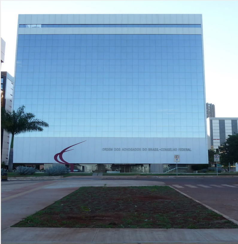
Figuras 16: Edifício OAB. Fonte: photobucket.com
