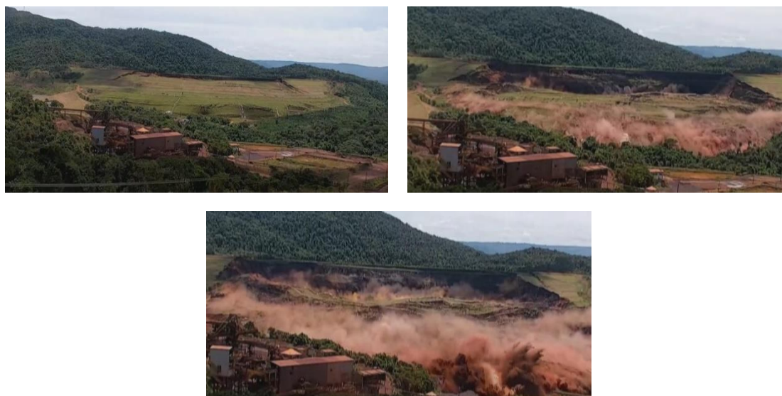
Figura 2. Rompimento da barragem 1 da Mina Córrego do Feijão, 2019. Fonte: https://bityli.com/Hh8pH
