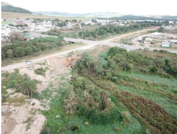
Figura 4- Imagem aérea da Avenida Ponte Grande em trecho onde já foi feita a instalação da rede de esgoto e o traçado da rua está pronto.
