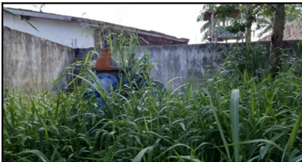
Figura 4: Condição da área do poço 7.
