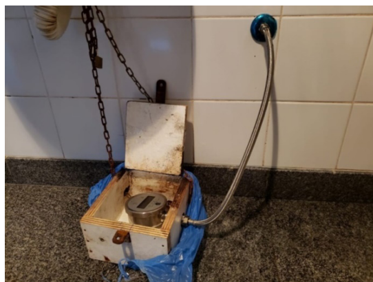
Figura 4. Instalação do manômetro no banheiro B1-633/62.
