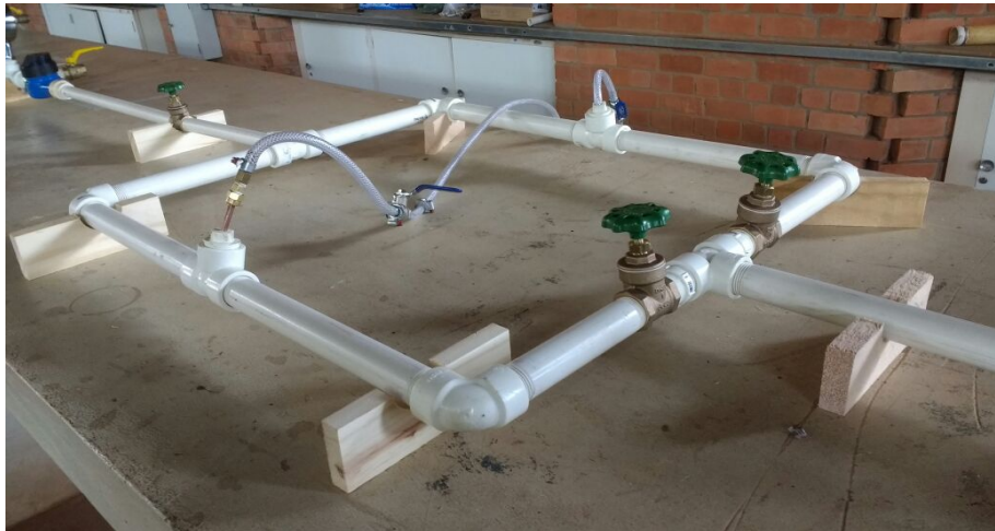
Figura 9 – Detalhe da ramificação da bancada de teste.
