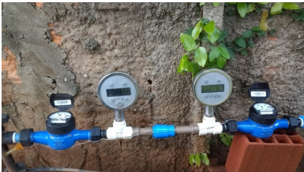
Figura 34 – Cavalete com a instalação do bloqueador de ar Aquamax em campo.
