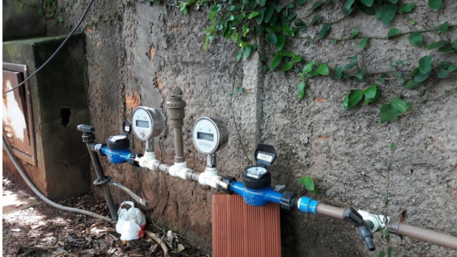
Figura 31 – Montagem do cavalete em campo com a válvula ventosa.
