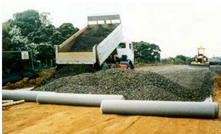
Figura 2.3 – Geotêxtil utilizado como reforço de rodovia
