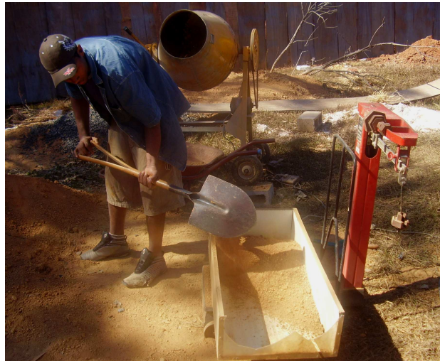
Figura 5.3 – Pesagem do solo a ser colocado na betoneira.
