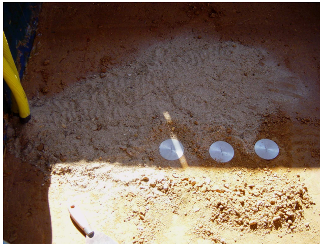
Figura 5.10 – Colocação das Células de Tensão Total.
