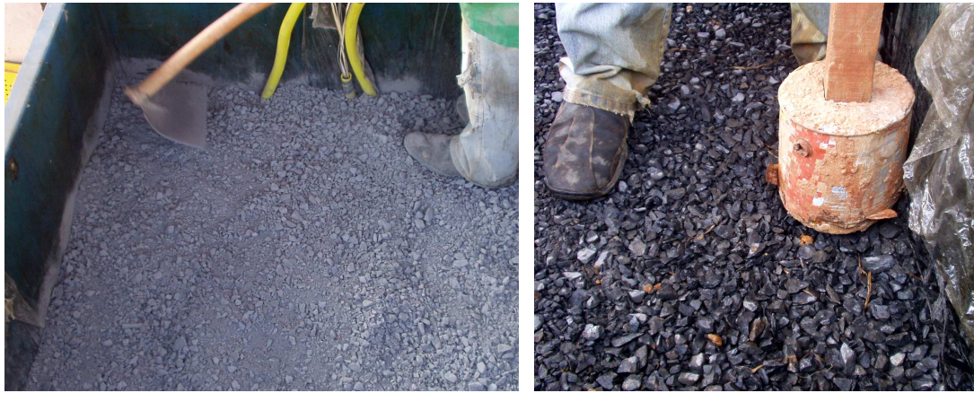
Figura 5.17 – Espalhamento e compactação da brita.
