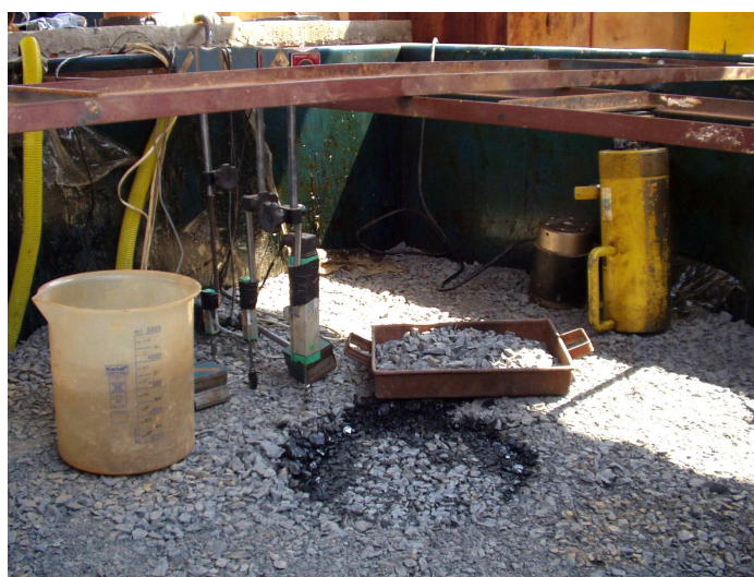
Figura 5.23 – Restauração da superfície deformada.
