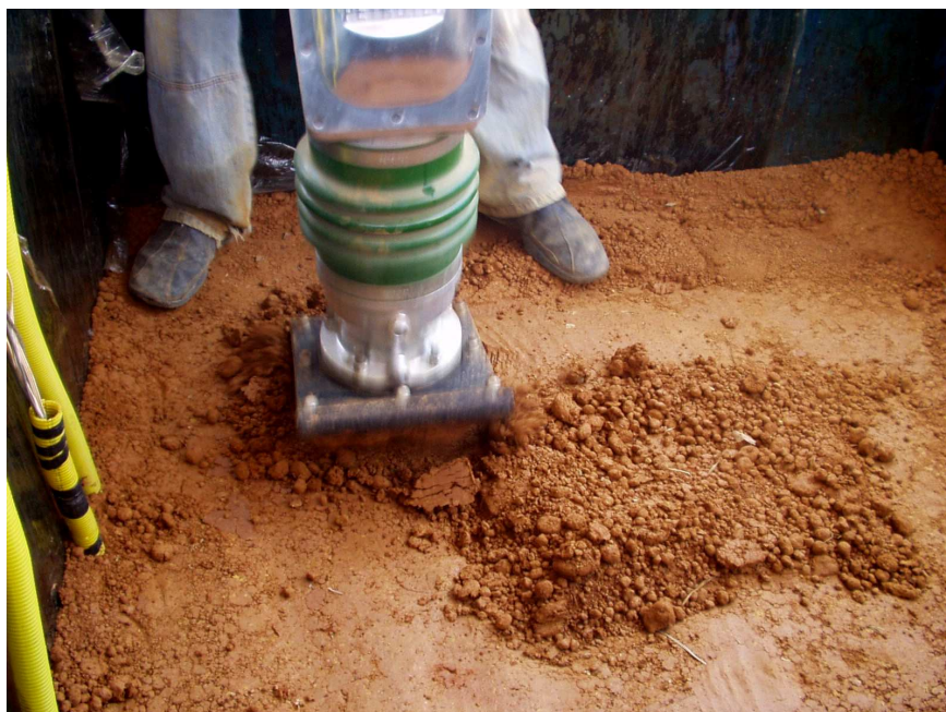
Figura 5.6 – Compactação do solo com o auxílio do “sapo”.
