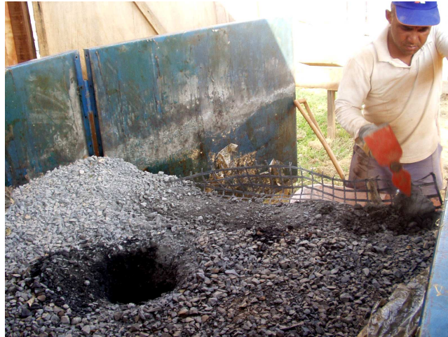
Figura 5.25 – Retirada da camada de base.
