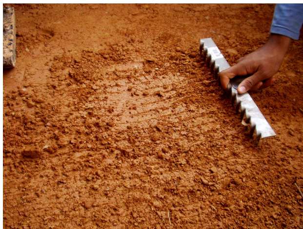
Figura 5.8 - Escarificação da superfície.
