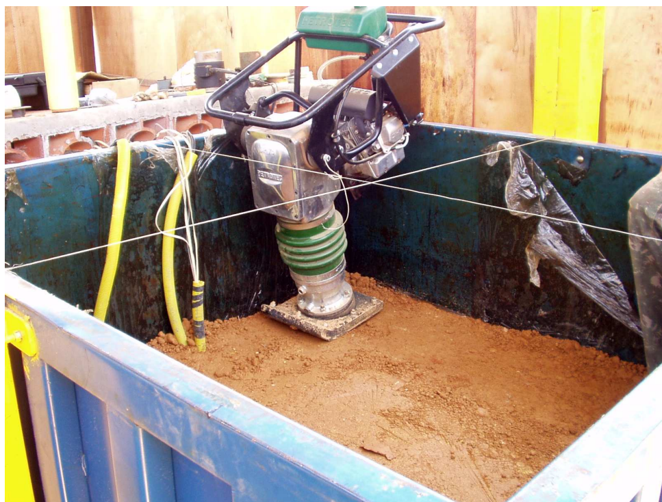
Figura 5.7 – Medição da altura da camada compactada.
