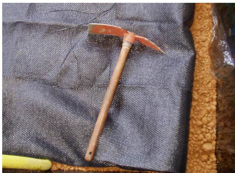
Figura 5.14 – Colocação do geotêxtil na interface entre subleito e base granular.
