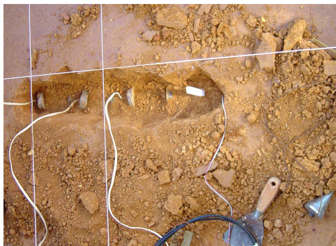
Figura 5.11 – Instalação dos Extensômetros Elétricos.
