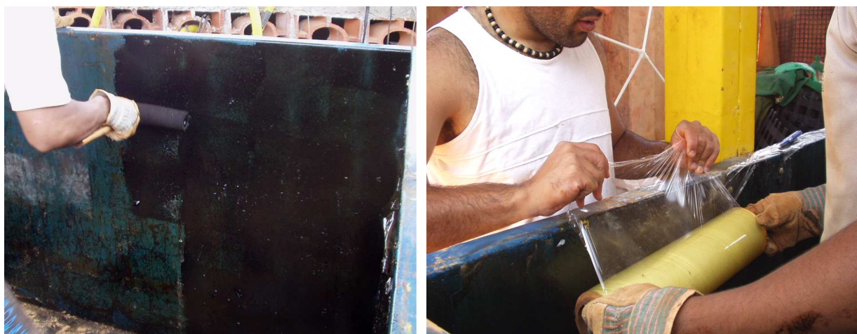
Figura 5.1 – Passagem da demão de óleo e fixação da camada de filme plástico.
