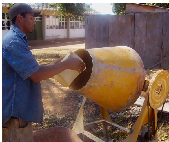
Figura 5.4 – Homogeneização do solo com auxílio de betoneira.
