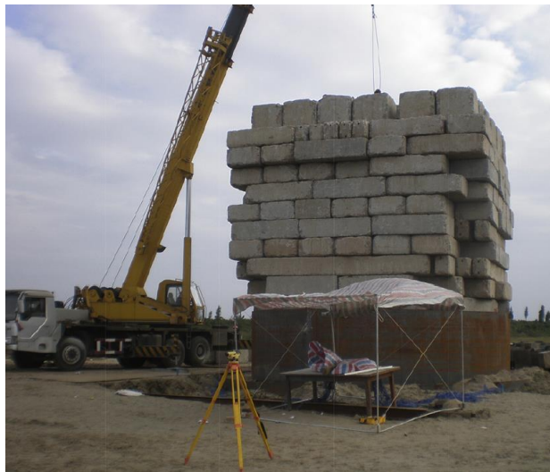
Figura A.1: Aplicação de sobrecarga com elementos de concreto (Haofeng et al., 2014)
