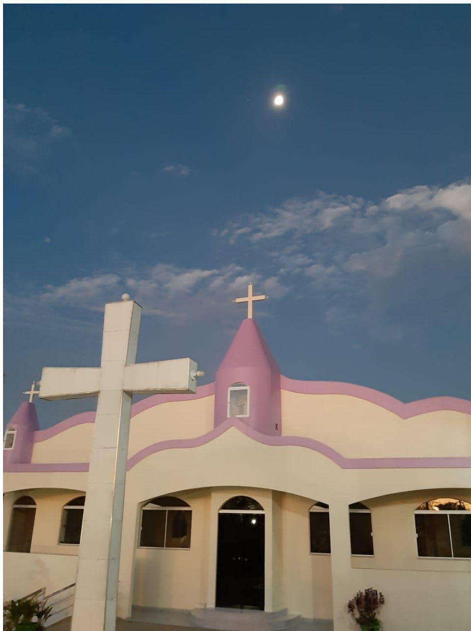
Foto 12 – Fachada do templo do CEOCPE, 2019. Fonte: Acervo CEOCPE
