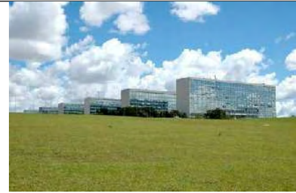
Esplanada dos Ministérios – Bsb. Não possui nenhuma entrada voltada para ela, definindo um espaço cego. Fonte: Frederico de Holanda
