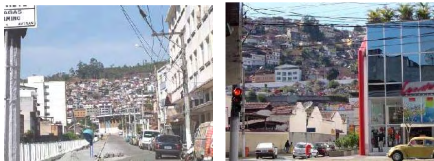
Fig.43 (Ano: 2007) e 44 (Ano: 2006) – Trecho do centro com um grande adensamento de edificações sobre as encostas dos morros da região.
