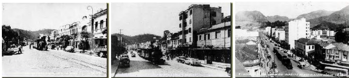
Fig. 21, 22 e 23 – Ramal ferroviário que cortava o centro da cidade. – Séc. XX.
