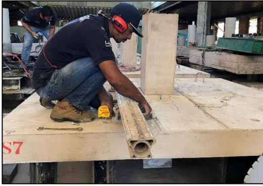
a) Posicionamento dos trilhos por onde a máquina de corte passa
