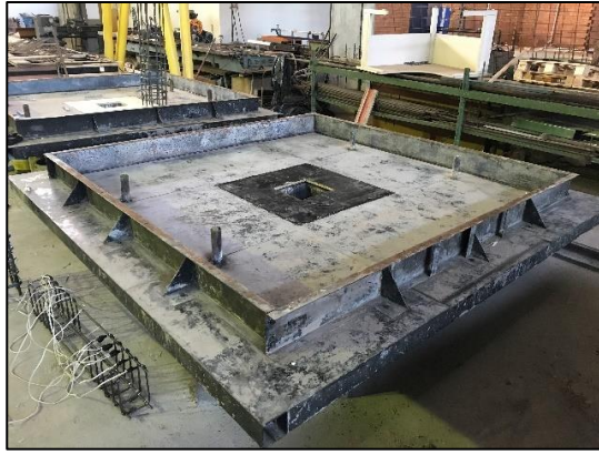
a) Fôrma já travada e vedada.
