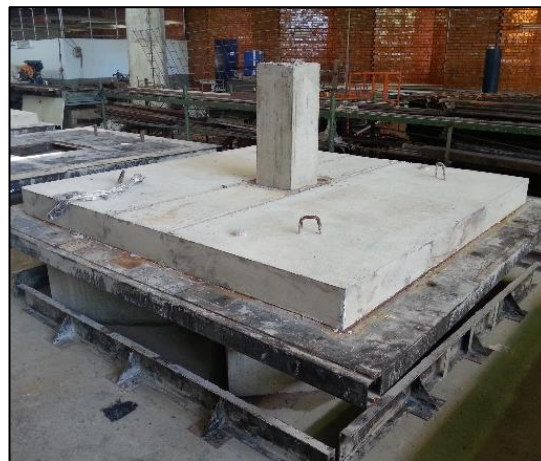
f) Desforma das lajes
