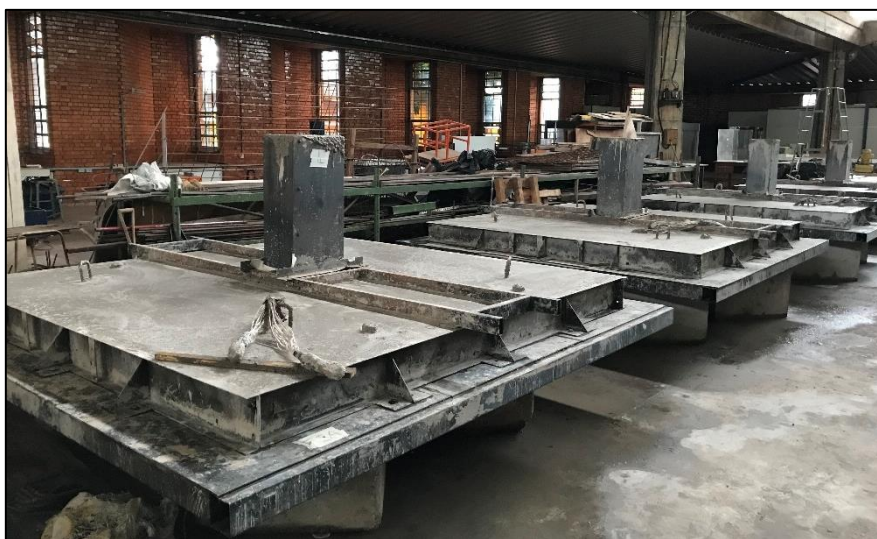
Figura 3.52 – Lajes já concretadas
