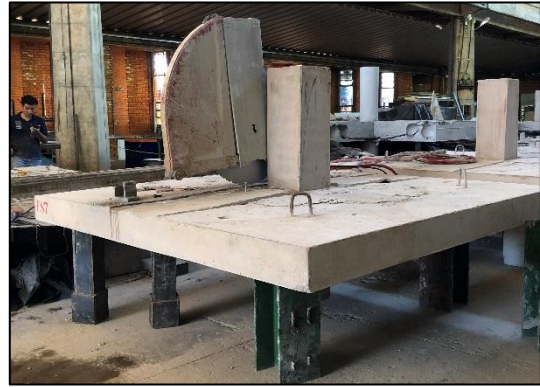
b) Máquina de corte já posicionada
