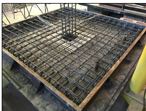
a) Laje RS posicionada na fôrma
