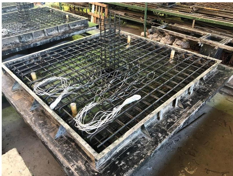
Figura 3.48 – Laje já com toda a instrumentação das barras de flexão e dos estribos de punção posicionados, pronta para concretagem
