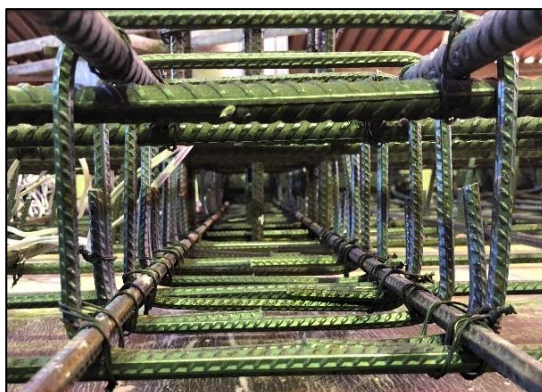
a) Ancoragem total – laje FA-04
