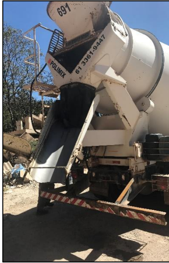
a) Recebimento do concreto
