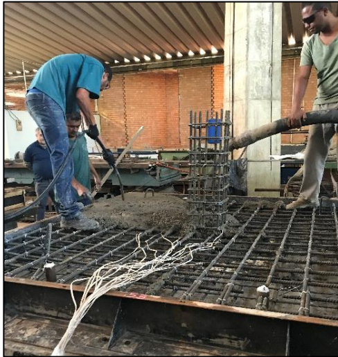
c) Durante a concretagem e vibração
