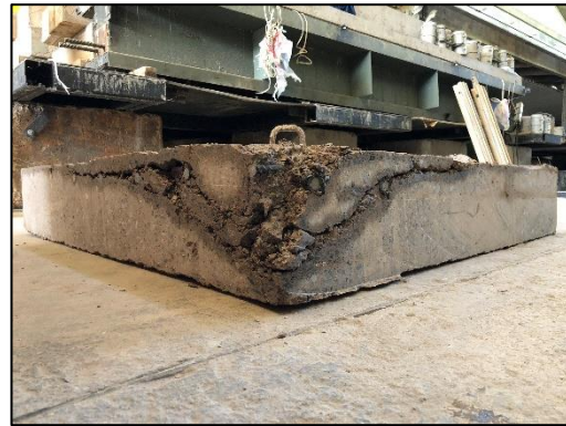
d) Quadrante retirado da laje
