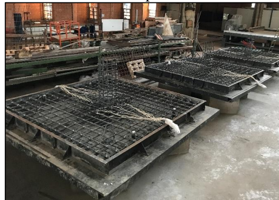
d) Armaduras já posicionadas nas fôrmas
