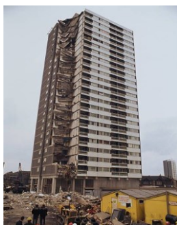
b) Colapso progressivo no Edifício Ronan Point, Londres (Subramanian, 2014)
