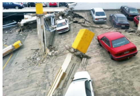
c) Colapso parcial de um pátio de estacionamento, em Christchurch, Nova Zelândia (Paiva et al. , 2015)
