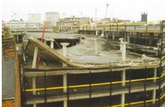
a) Colapso parcial do edifício Pipers Row Car Park, Inglaterra (Wood,1997)
