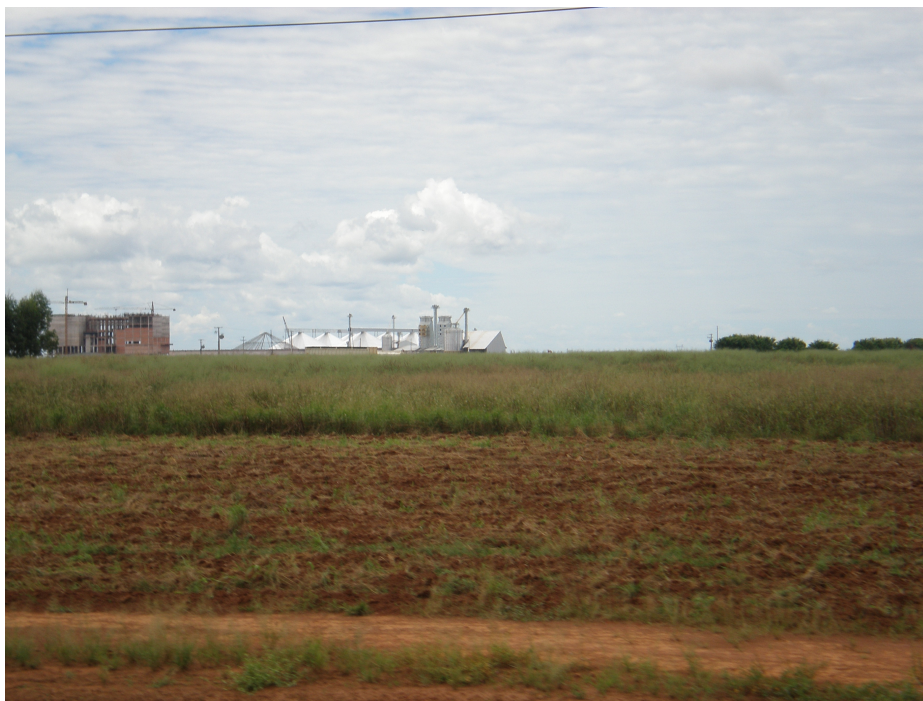
Obras da construção do complexo agroindustrial da Sadia em LRV. Foto: Luis Gustavo Maciel.
