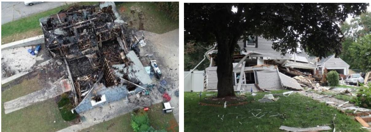
Figura 2. 6. Explosão provocada pela ruptura de tubo (NTSB, 2018).
