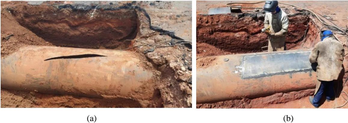
Figura 2. 5. (a) Ruptura de adutora durante serviço de manutenção (G1, 2020a); (b) Reparação da adutora (G1, 2020b).
