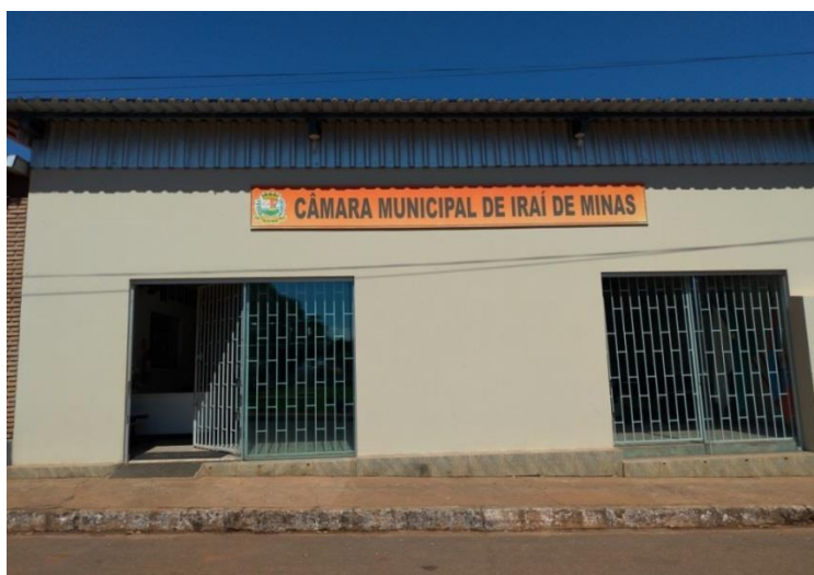
Figura 4 – Câmara Municipal de Iraí de Minas, frente
