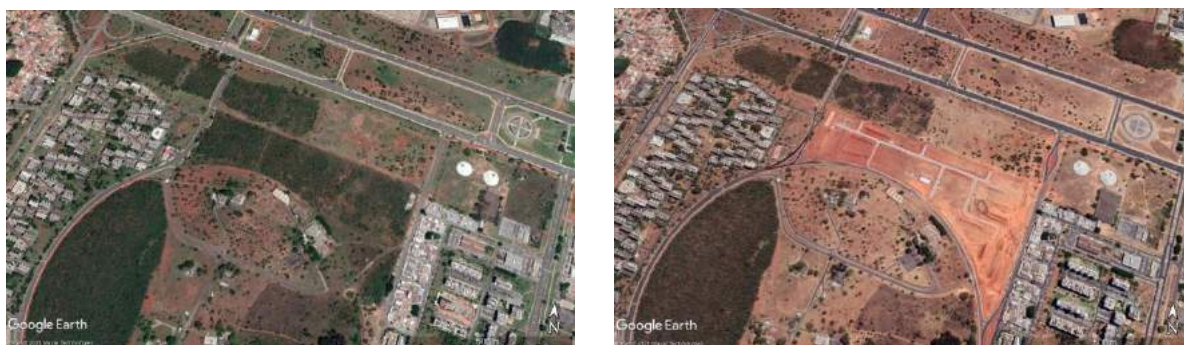
Figura 50 - Fotografia aérea terreno antes e na construção da Superquadra 500.
