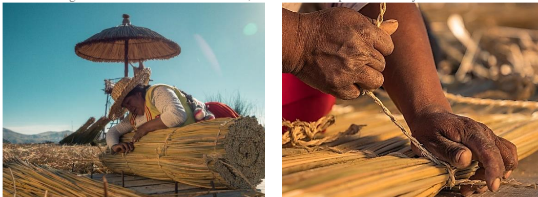
Figura 30: Armado de la “Kesana”, material usado para el techo y muros de la vivienda
