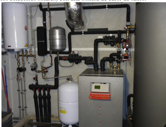
Figura 10: Cooperación del sistema de calefacción solar combinado (parte interior, es decir, excluidos los colectores solares) con una bomba de calor de suelo.
