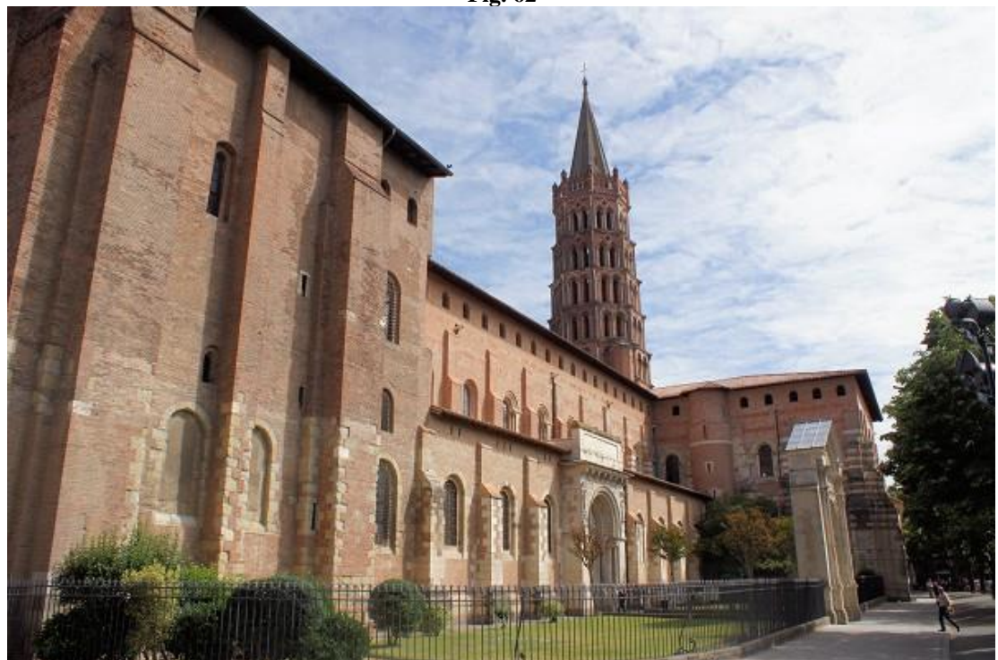
(Contrafortes e aberturas. Fachada Sul. Basílica Saint-Sernin, Toulouse, França) 278
