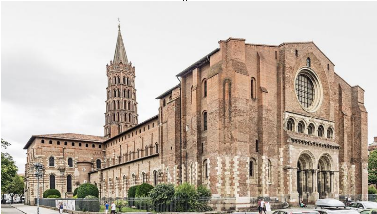
(Vista Noroeste. Fachada oeste simétrica. Torres incompletas. Basílica Saint-Sernin, Toulouse, França) 286
