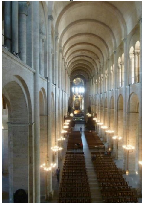
(Abóbada de berço e arcos romanos. Nave central. Basílica Saint-Sernin, Toulouse, França) 309
