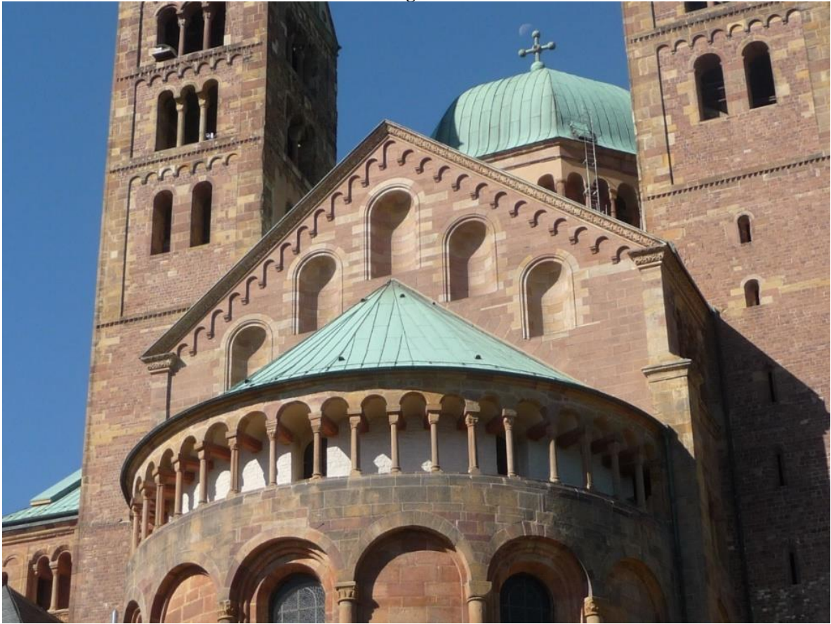
(Arcada cega ou “banda lombarda”. Fachada da Catedral de Speyer. Speyer, Alemanha – 1106) 204
