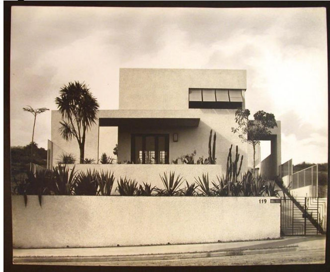
Figura 9 – Fachada da Casa Modernista, 1930.
