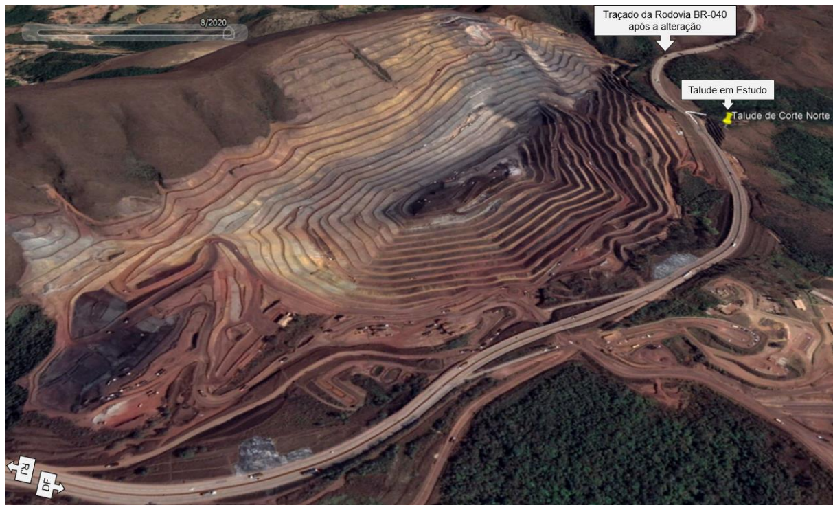
Figura 3.2. Imagem aérea do traçado atual da Rodovia BR 040 na área de estudo (Google Earth, 2021).
