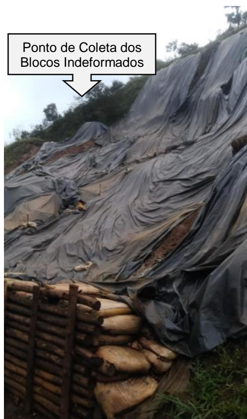
Figura 4.2. Ponto de coleta de Bloco Indeformado para realização de ensaios.
