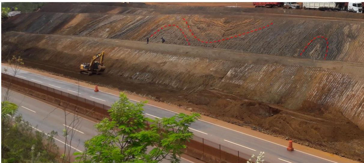
Figura 2.9. Dobras anticlinais e sinclinais na face do talude sul.
