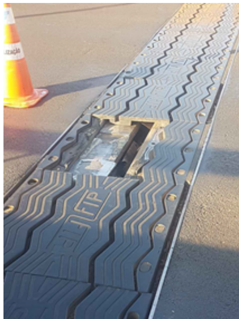
Figura 22 - Juntas de Dilatação Ponte JK Brasília-DF
