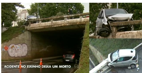
Figura 3: Colisão direta com proteção de concreto armado no Eixinho Norte.
