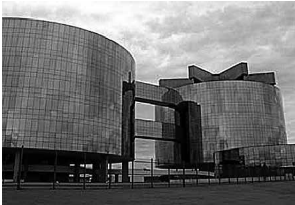
Figura 27: Vista externa do Prédio da Procuradoria Geral da República.
