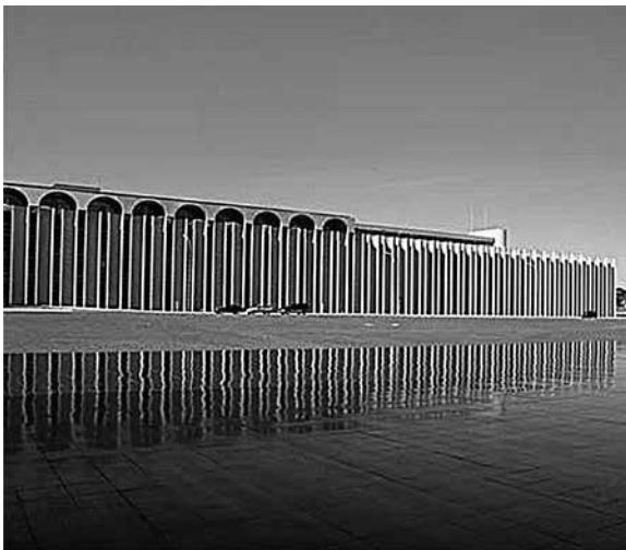
Figura 14: Fachada bloco principal do Quartel-General do Exército, em Brasília.
