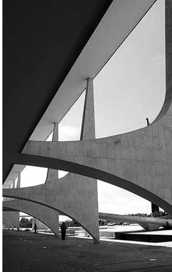
Figura 6: Detalhe das colunas do Palácio Planalto, mostrando o engrossamento posterior na base do pilar.
