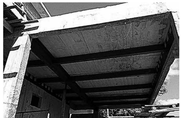
**Figura 30:** Vigas metálicas sendo soldadas em obra.
