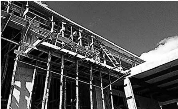
Os pilares circulares, foram reforçados com novas armaduras, colocados e novas formas e reconcretados, como mostra o esquema da Figura 27.
