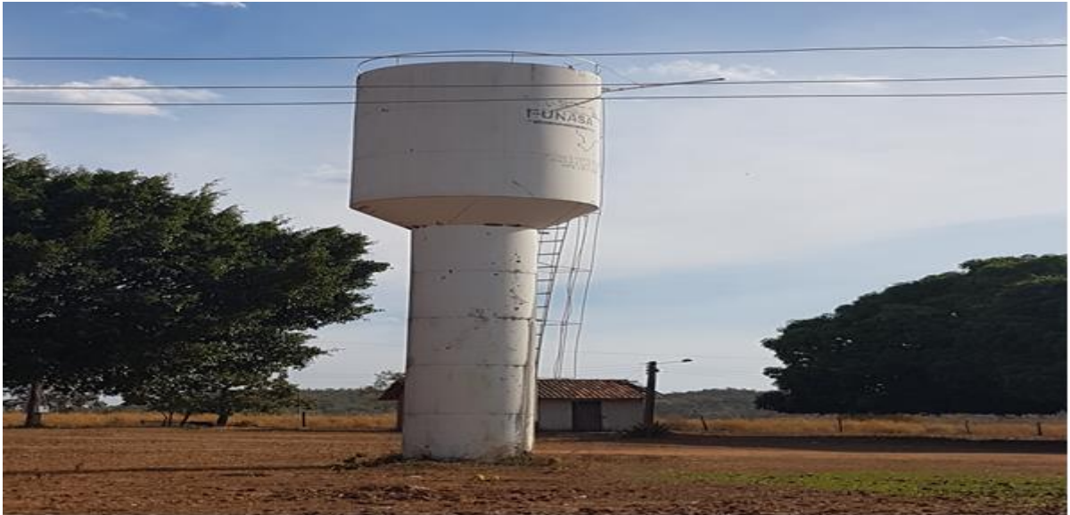
Caixa d'água de poço artesiano que abastece a Gleba I da TI Carretão, construído pela Funasa. GO, Jun.2019
