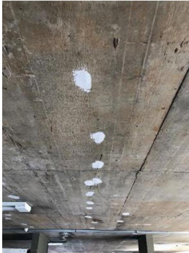
Figura 66: Monitoramento fissuras com placas de gesso.
