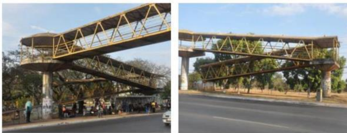
Figura 26: Passarela de estrutura mista avaliada.
