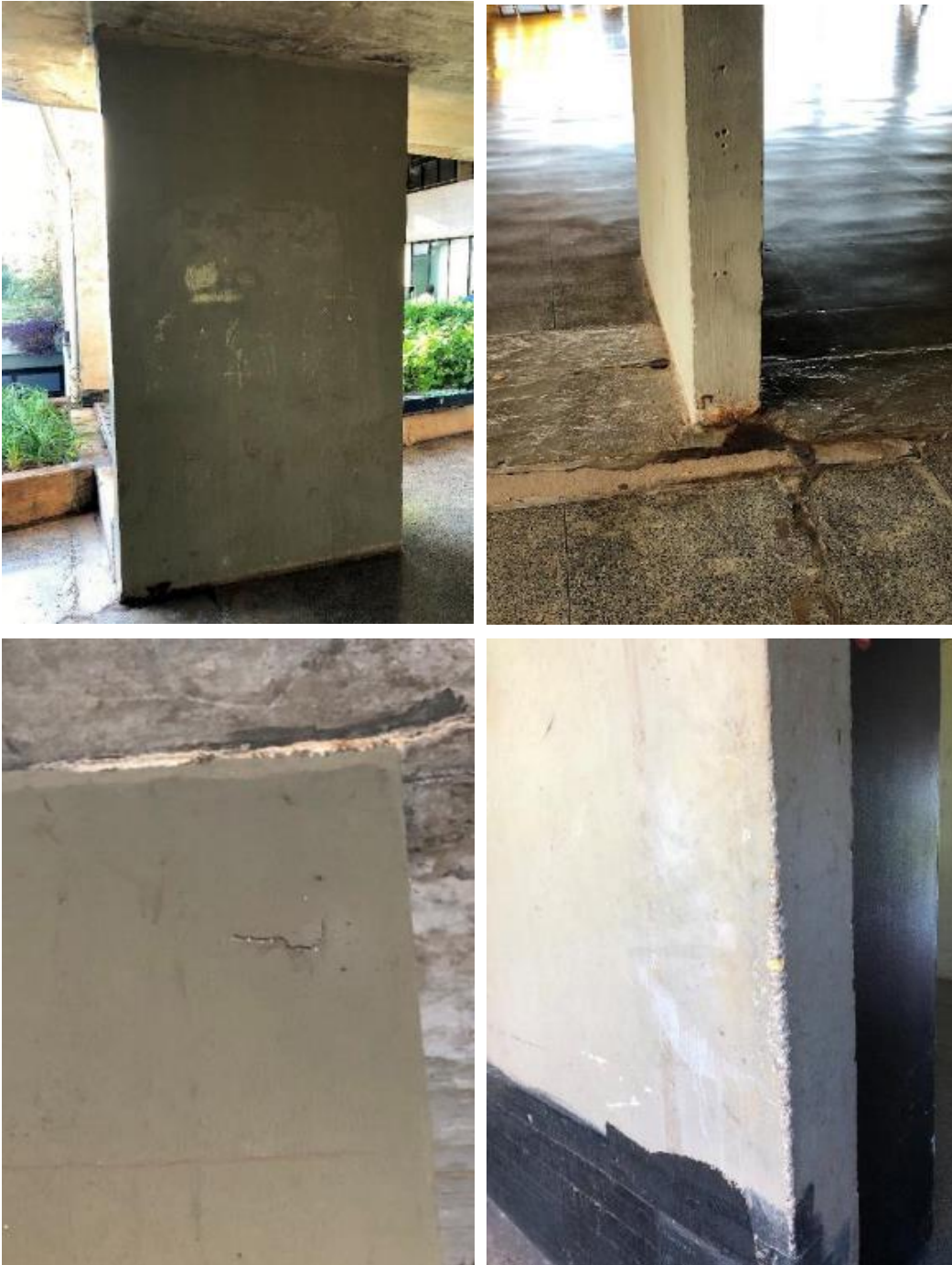
Figura 70: Pilares - Mezanino ICC Norte.
