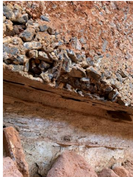
Figura 36. Armadura exposta e corroída, cobrimento deficiente; falha de concretagem; desagregação.
