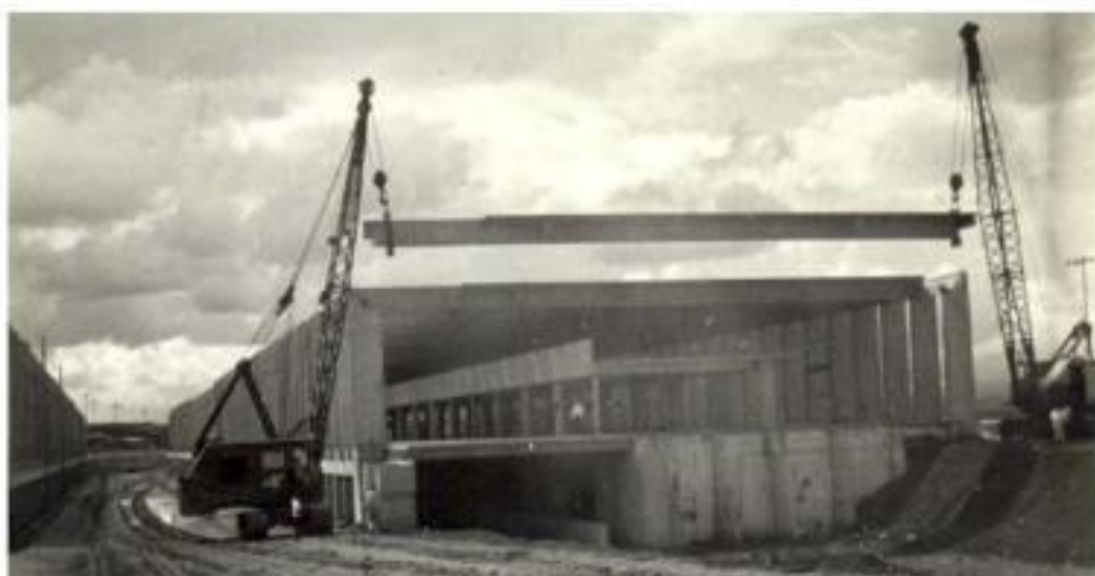
Figura 60: Instalação de vigas pré-moldadas.
