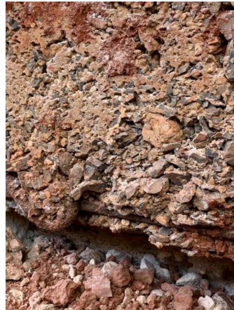
Figura 44. Armaduras expostas e corroídas; cobertura deficiente; falhas na concretagem.
