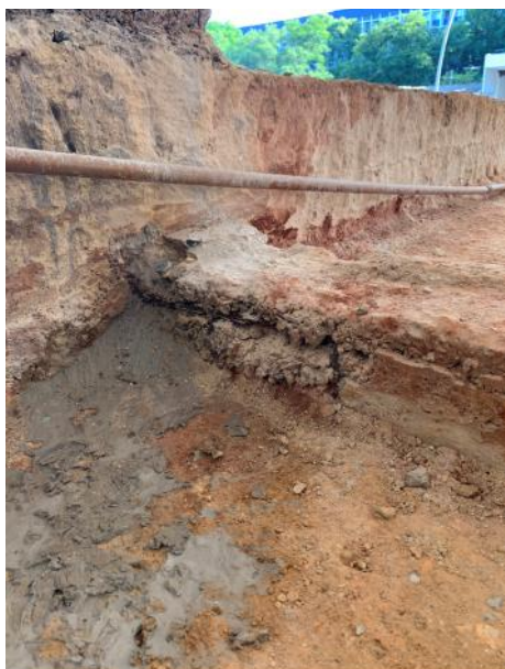
Figura 107. Armadura exposta e corroída; cobrimento deficiente; desagregação; deslocamento; falhas de concretagem
