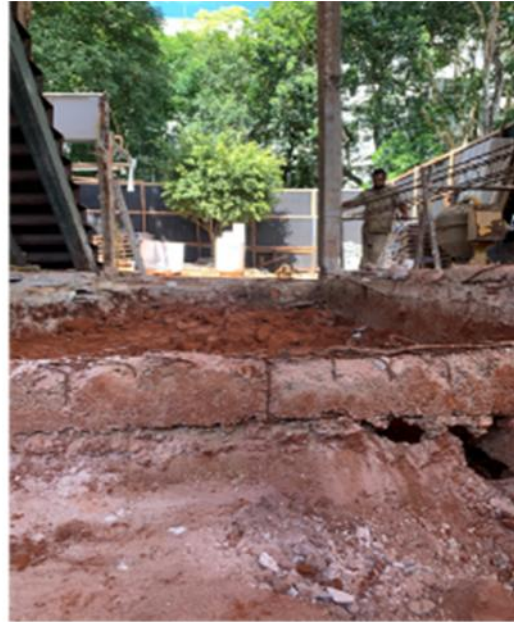
b) Armadura exposta e corroída; cobrimento deficiente; desagregação; deslocamento; falhas de concretagem.
