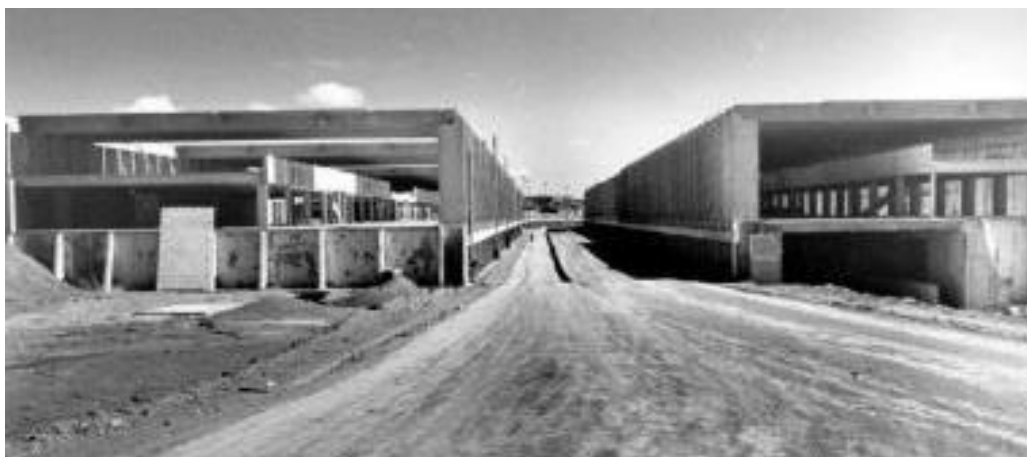
Figura 59: Construção do ICC.
