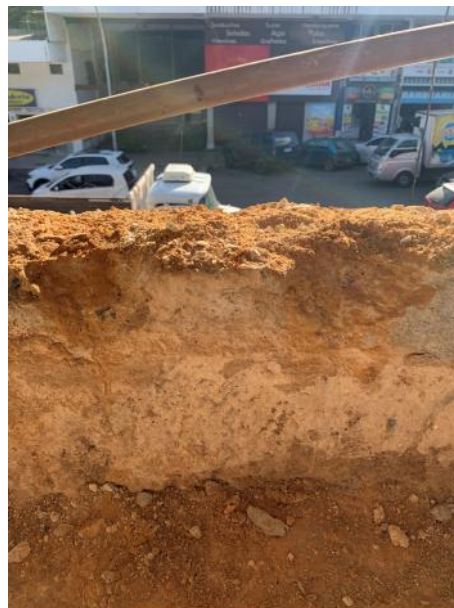
Figura 102. Desagregação; deslocamento; falhas de concretagem.
