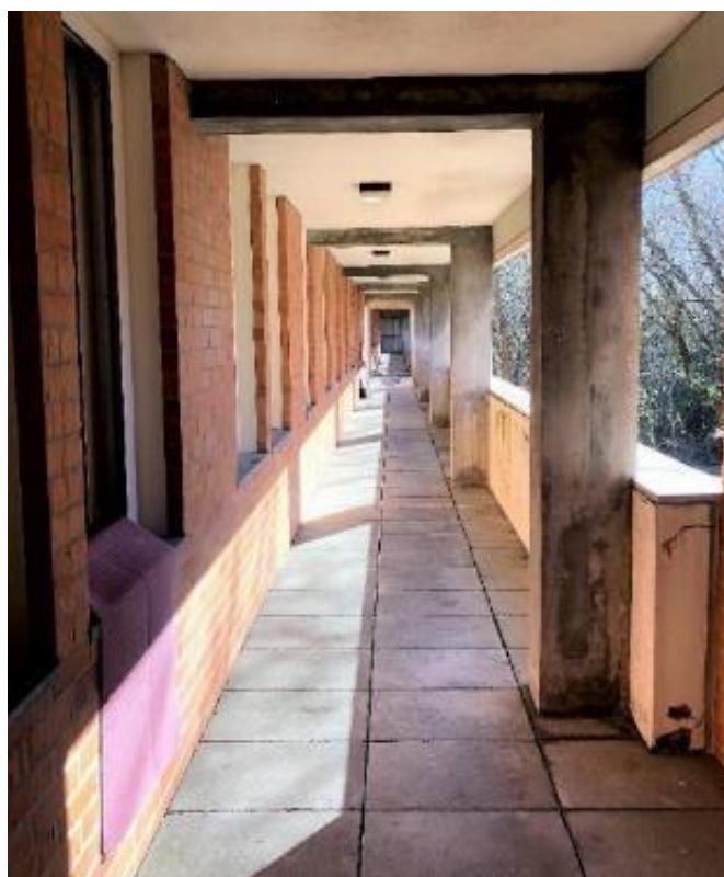
Figura 44: Visão geral das vigas e pilares.
