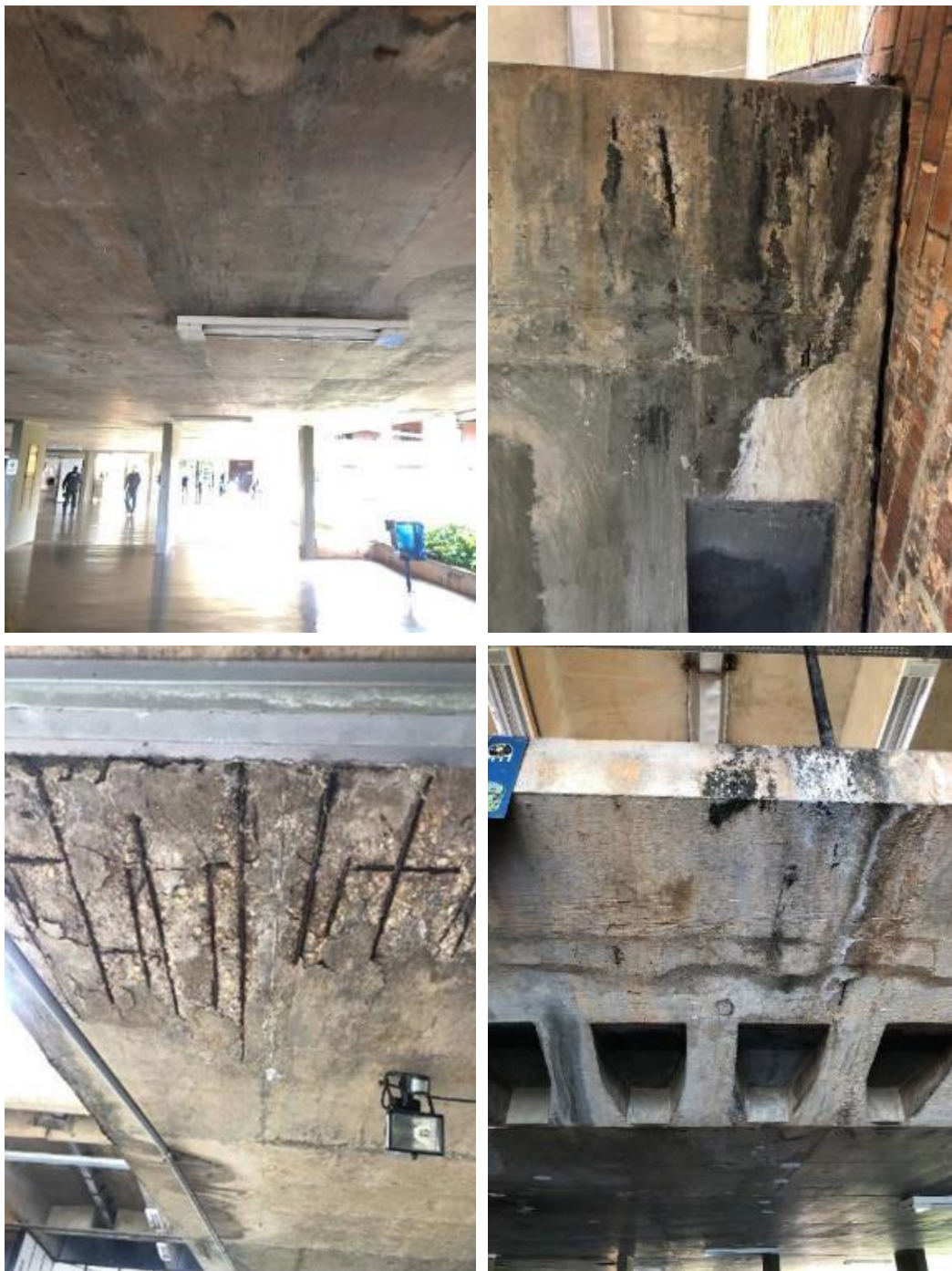
Figura 71: Laje Mezanino ICC Norte.
