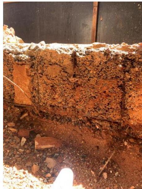
Figura 52. Armadura exposta e corroída; cobrimento deficiente; falhas de concretagem.
