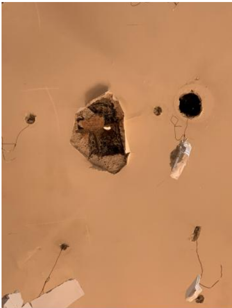
Figura 115. Armadura exposta e corroída; cobrimento deficiente; desagregação; deslocamento falhas de concretagem.
