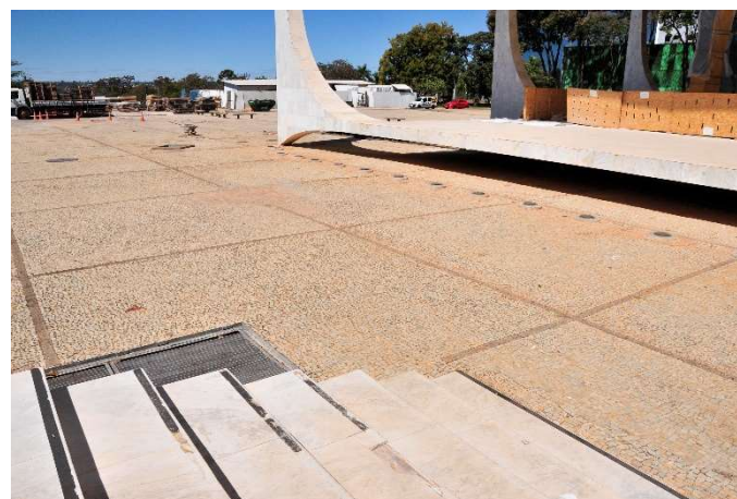
ESCADA DE ACESSO À ENTRADA PRINCIPAL
