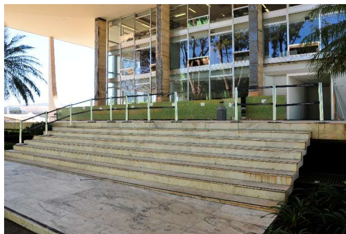
ESCALADA DE ACESSO À ENTRADA SUL
