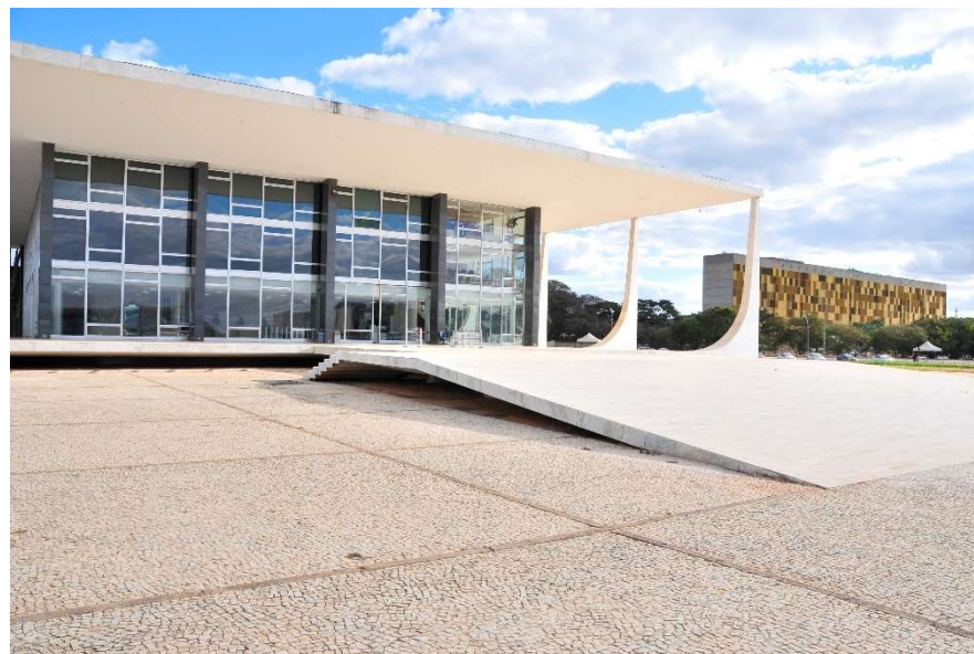
FIGURA 44 – FACHADA NORTE DO PALÁCIO DO STF – RAMPA E ESCADAS EM MÁRMORE.
