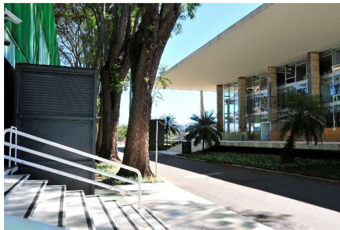
ESCADAS DO ANEXO I E DA ENTRADA SUL DO PALÁCIO
