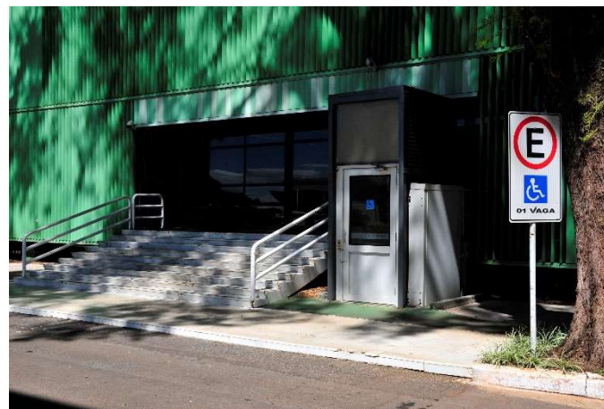
PLATAFORMA ELEVATÓRIA NO ACESSO AO ANEXO I
