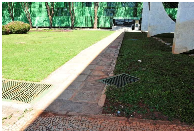
GRELHAS NO PISO NA ROTA ACESSÍVEL
