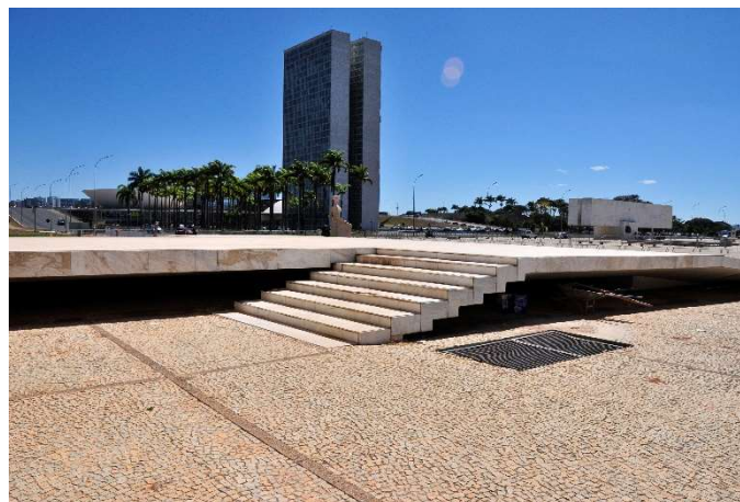
ESCADA DE ACESSO À ENTRADA PRINCIPAL
