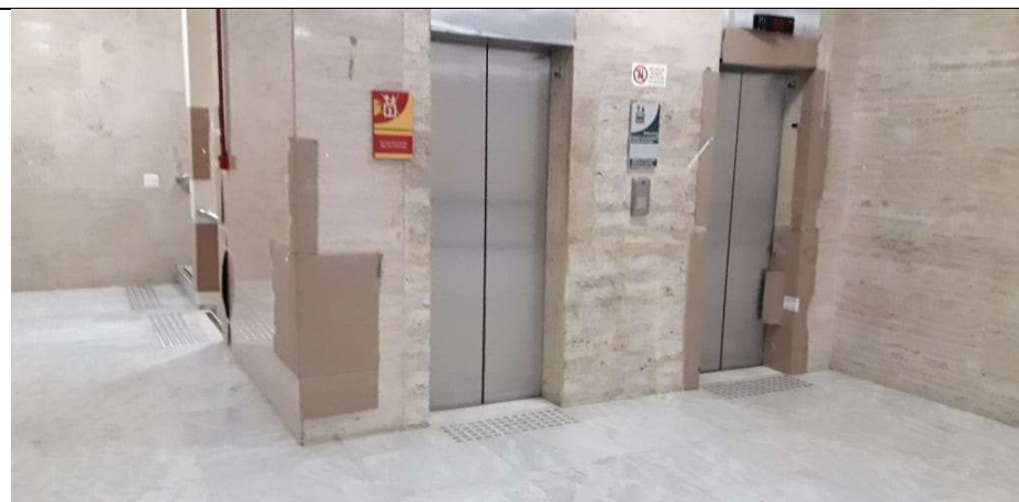
ELEVADORES E ESCADA DE SERVIÇO
