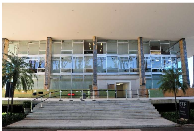
ESCADA DE ACESSO À ENTRADA SUL
