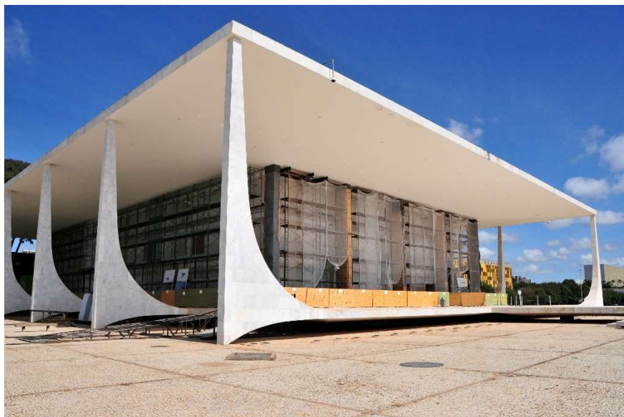
FIGURA 36 – OBRA DE RESTAURAÇÃO DAS FACHADAS DO PALÁCIO DO STF – MAIO DE 2020.
