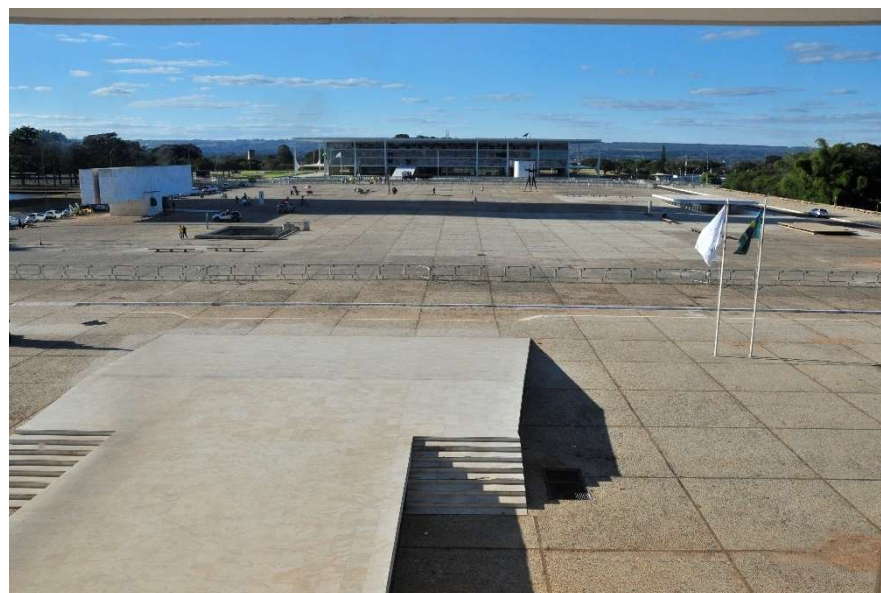
FIGURA 42 – RAMPA PRINCIPAL DO PALÁCIO DO STF E A PRAÇA DOS TRÊS PODERES.
