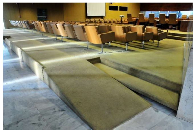
RAMPA PARA PESSOAS EM CADEIRAS DE RODAS NO PLENÁRIO
