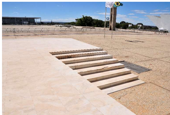
ESCADA DE ACESSO À ENTRADA PRINCIPAL
