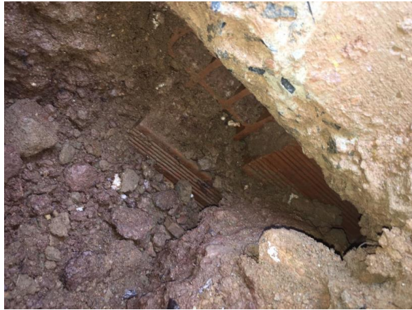
Figura 24 - Poço 3 - Blocos sobre tijolos cerâmicos
