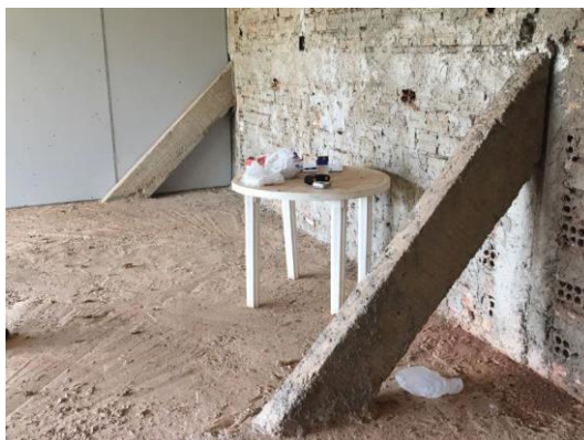
Figura 37 - Escoramento dos pilares no subsolo
