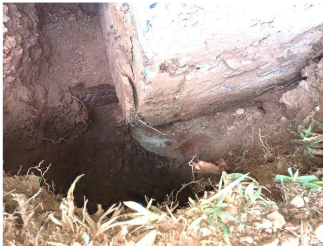
Figura 25 - Poço 2 - Bloco sob broca
