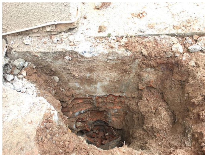
Figura 23 - Poço 1 - Blocos sobre tijolos cerâmicos
