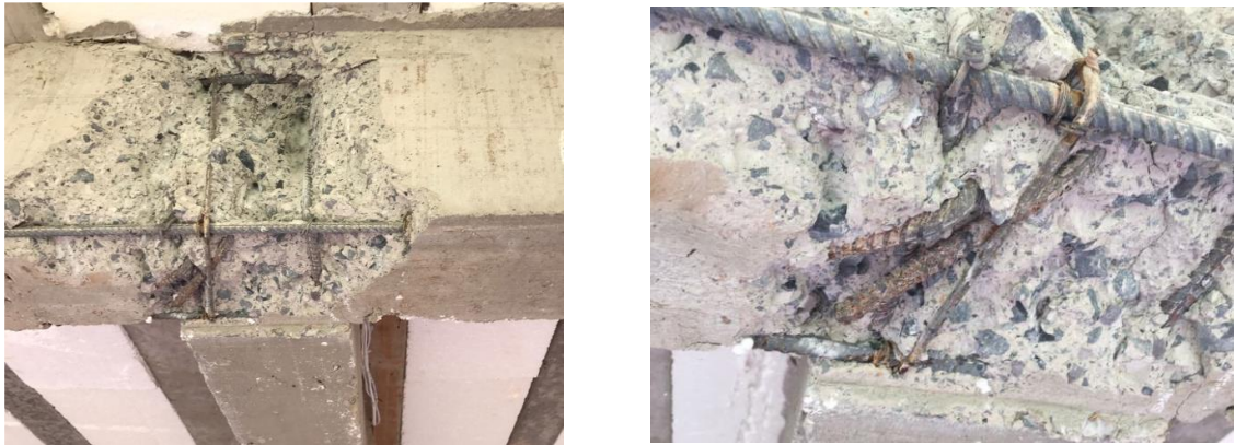
Figura 32 - Armaduras no cruzamento entre vigas
