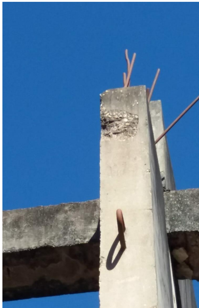
Figura 76 - Esperas dos pilares
