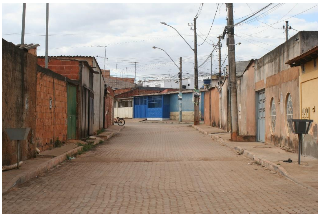
FIGURA 24: ILUMINAÇÃO PÚBLICA EM TRECHO REGULARIZADO
