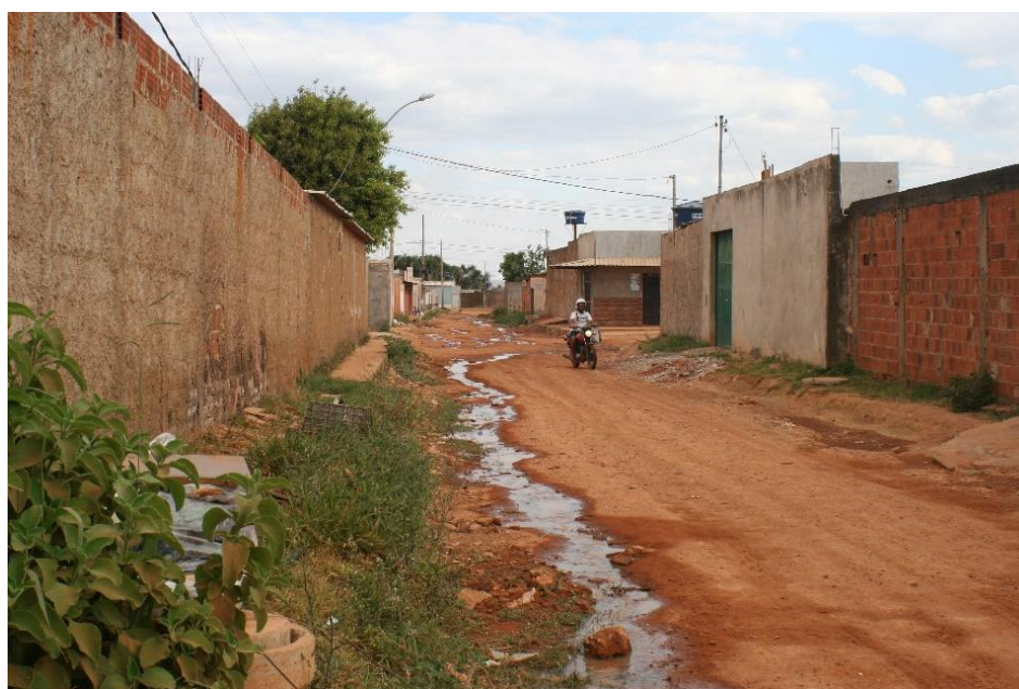
FIGURA 22: ESGOTO A CÉU ABERTO, SOL NASCENTE, TRECHO III
