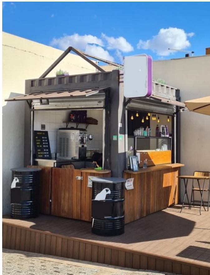
FIGURA 7 - VISTA GERAL DO QUIOSQUE A
