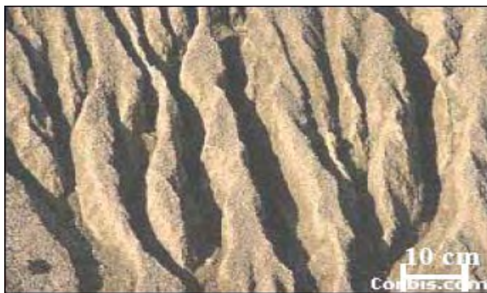
Figura 2.1 – Taludes às margens de uma rodovia com erosão em sulcos (Corbis, (2000) apud Silveira, (2002)).
