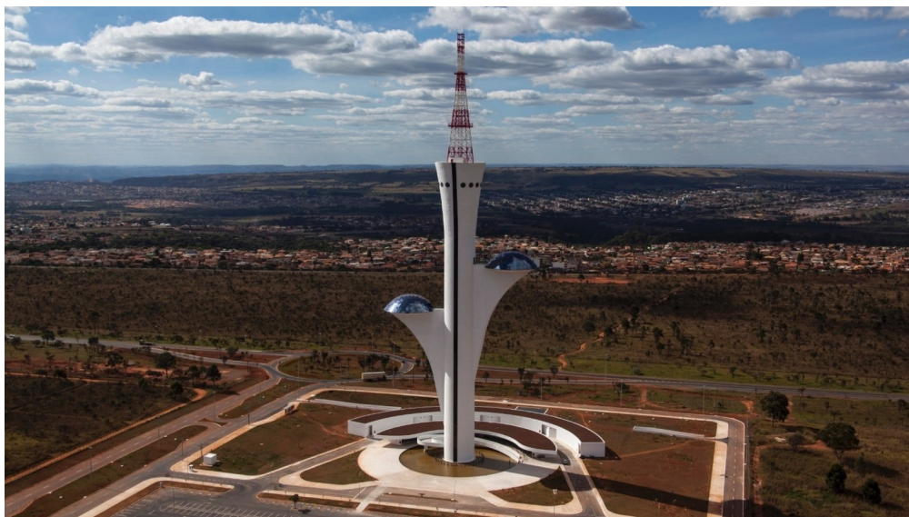
Figura 68. Torre de TV Digital de Brasília
