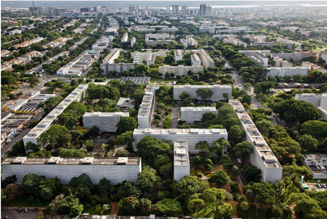
Figura 17: Prédio residenciais das Superquadras de Brasília
