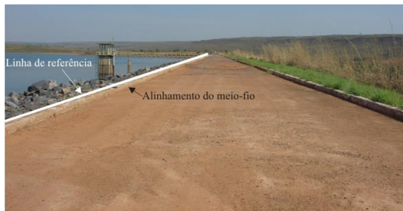
Figura 5.18 – Foto demonstrando o bom estado de conservação do pavimento e perfeito alinhamento do meiofio.
