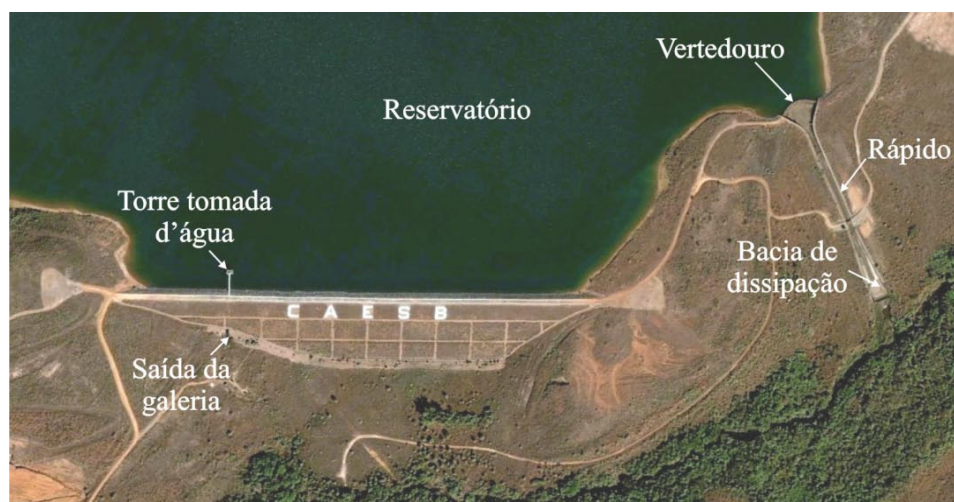
Figura 5.2 – Arranjo geral da barragem de Santa Maria (modificado - Google, 2009).
