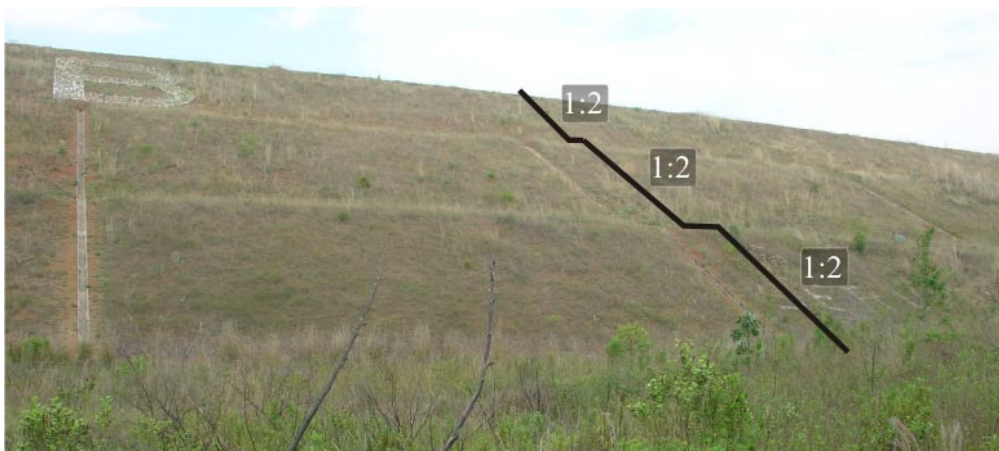
Figura 5.27 - Talude de jusante da barragem de Santa Maria sem indícios de movimentação ou deslocamentos de terra.
