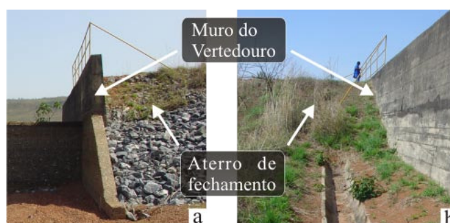
Figura 5.21 - Aterro na região do vertedouro: a) vista de montante; b) vista de jusante.
