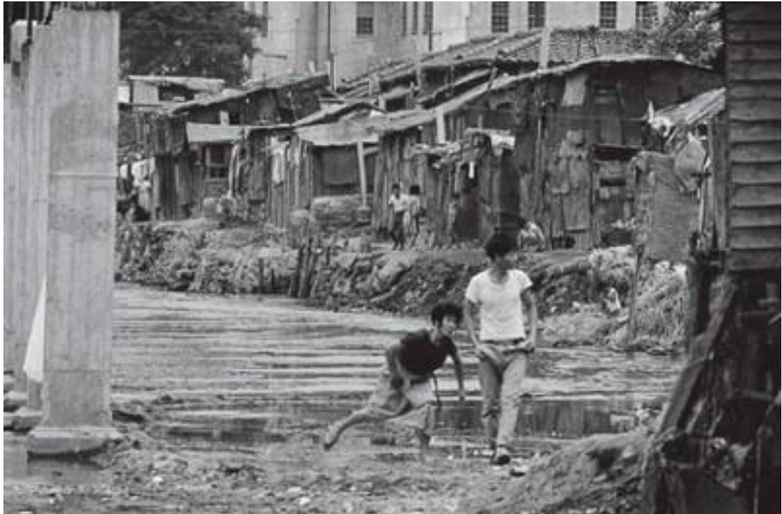
Foto 3. Rio Cheong Gye Cheon poluído e com ocupação irregular
