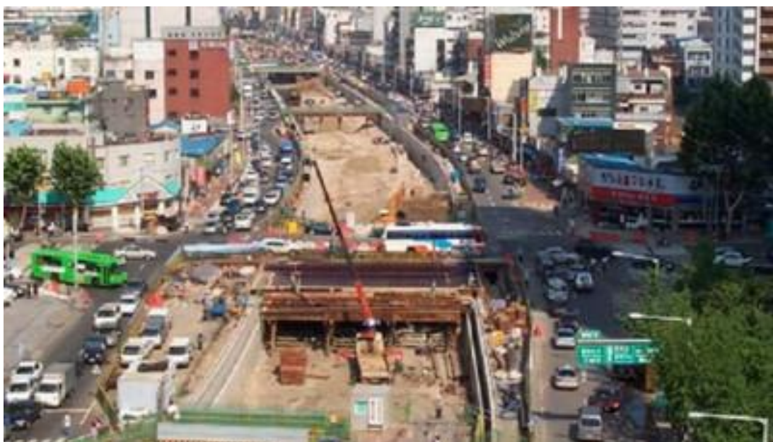
Foto 5. Obras de revitalização e retirada do viaduto. Fonte: Arroio Dilúvio (2021).
