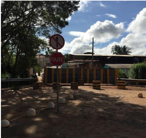
Foto 18. Trecho com rompimento da via
