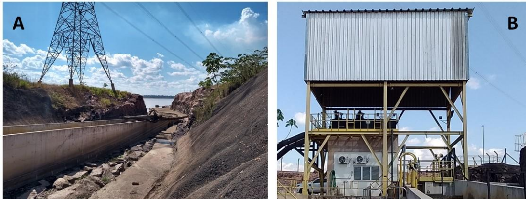
Figura 4. A) Rampa de acesso ao sistema de transposição de peixes. B) Detalhe do elevador do sistema de transposição de peixes.
