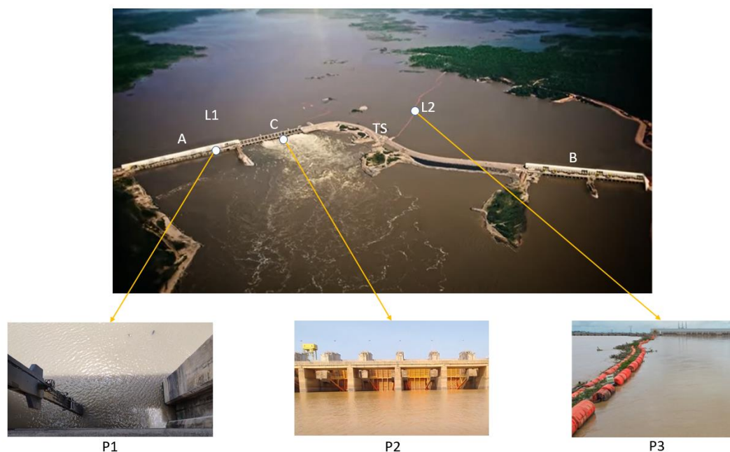
Figura 11. Distribuição das estruturas civis da UHE Jirau. A) Casa de Força 1 (UG01 a UG28); B) Casa de Força 2 (UG29 a UG50); C) Vertedouro (V01 a V18); L1) Sistema de Log Boom / margem direita; L2) Sistema de Log Boom / margem esquerda; TS) Sistema descarregador/transposição de troncos (STT).
