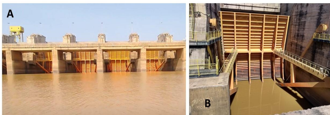
Figura 3. A) Vertedouro da UHE Jirau com as comportas fechadas. O monitoramento é feito no vão das comportas em busca de ictiofauna confinada nessa área. B) Detalhe de um dos vãos do vertedouro. Fonte: Autor (2022)
