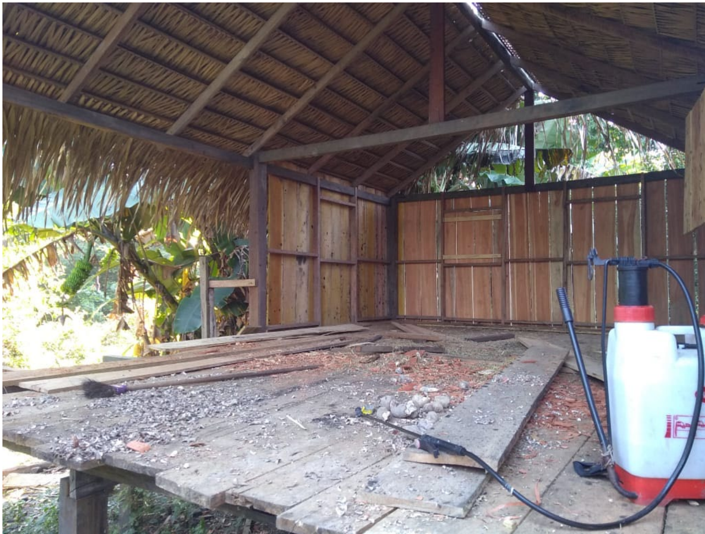
Figura 23. Construção de um dos paióis de armazenamento de açaí e castanha. Funcionou para quem mora perto do paiol; quem mora longe prefere não dar mais viagens e guarda em casa.
