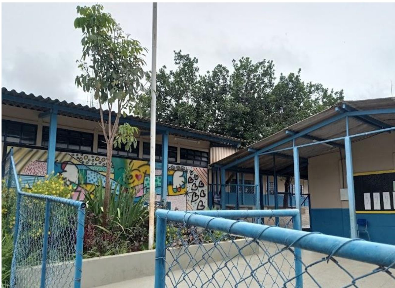
Figura 22 – Entrada do CEF01 VARJÃO
