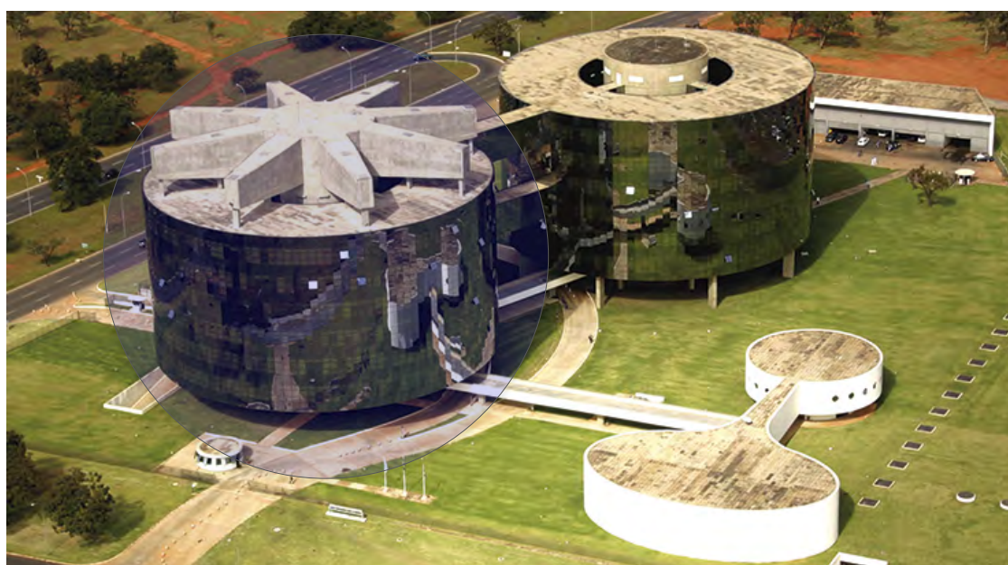
Figura 2. Bloco A do complexo da PGR, fonte: arquivo PGR
