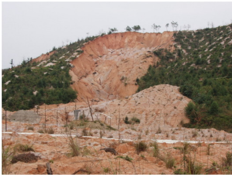
Figura 12 – Deslizamento causado pela injeção inadequada dos reagentes para extração dos ETR diretamente sobre a cobertura saprolítica. Fonte: (DIAN, 2000 apud ZHANG et al., 2016).
