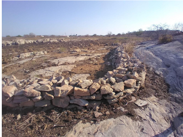
Figura 2 - Vista de parte do muro de pedras
