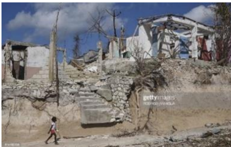
Fig.22 : Image des maisons endommagées dans l'entrée du centre-ville
