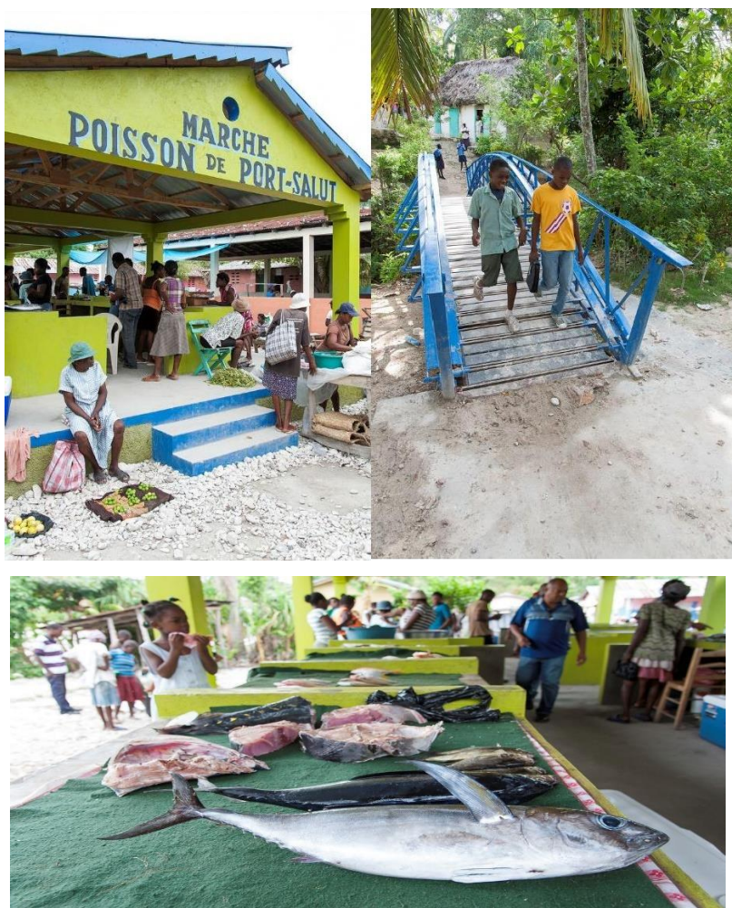
Fig.9 : Images de quelques réalisations de l'Unops (marché de poisson et un petit pont métallique).
