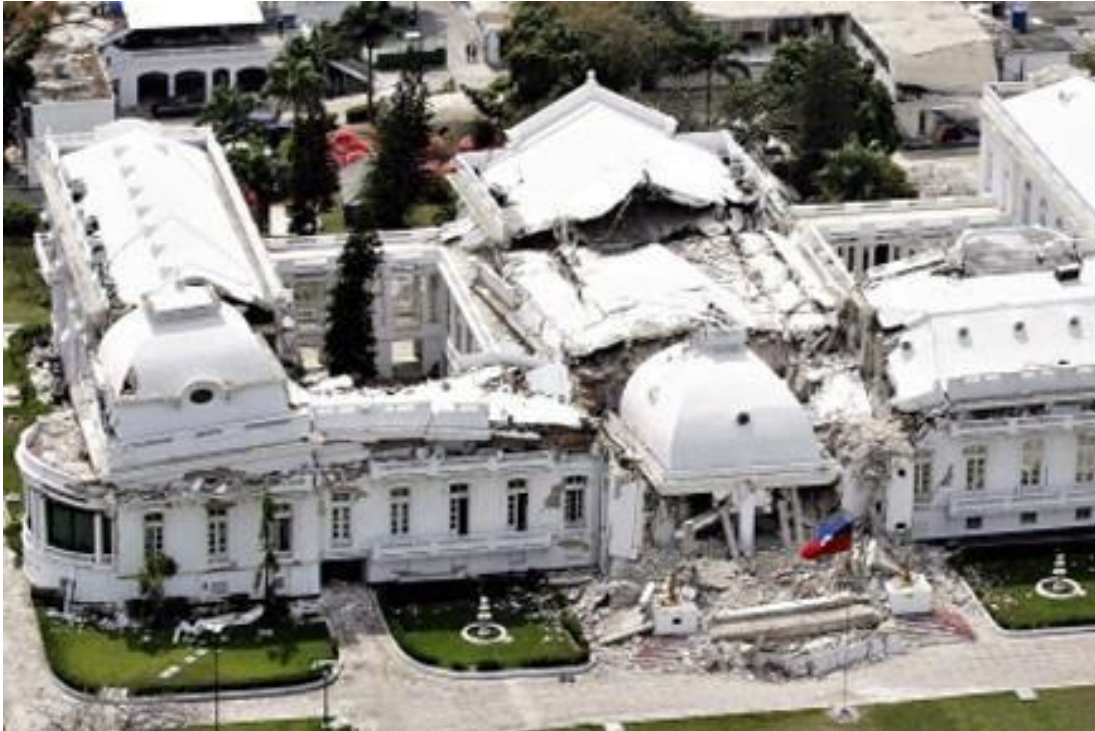
Fig. 2 : Image du palais National après le séisme de 2010.
