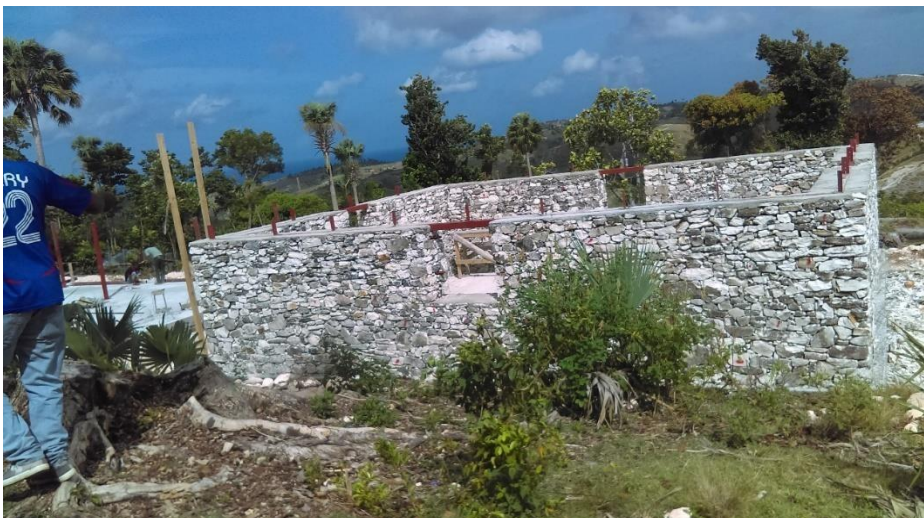
Fig.8 : Image du premier compartiment de l'abri provisoire en construction en 2019 dans la 4 ème Section.
