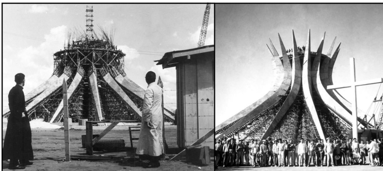
Figura 28 – Etapas da construção da estrutura da Catedral [1959 - 1960]
