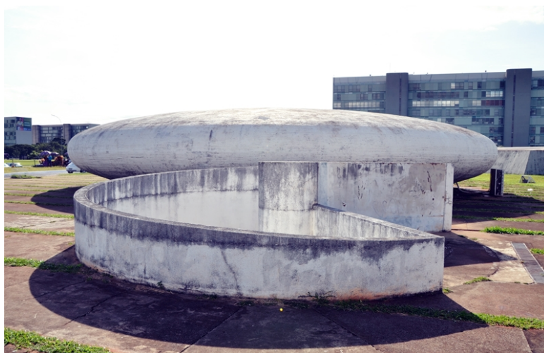
Figura 40 – Batistério e sua escada de acesso exterior
