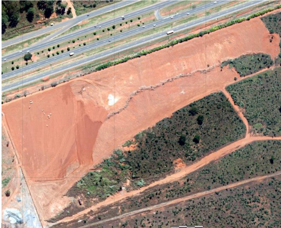
Figura 3.4 – Caixa de empréstimo no Parque Rodoviário do DER/DF, em 2014 (Geoportal, 2020).
